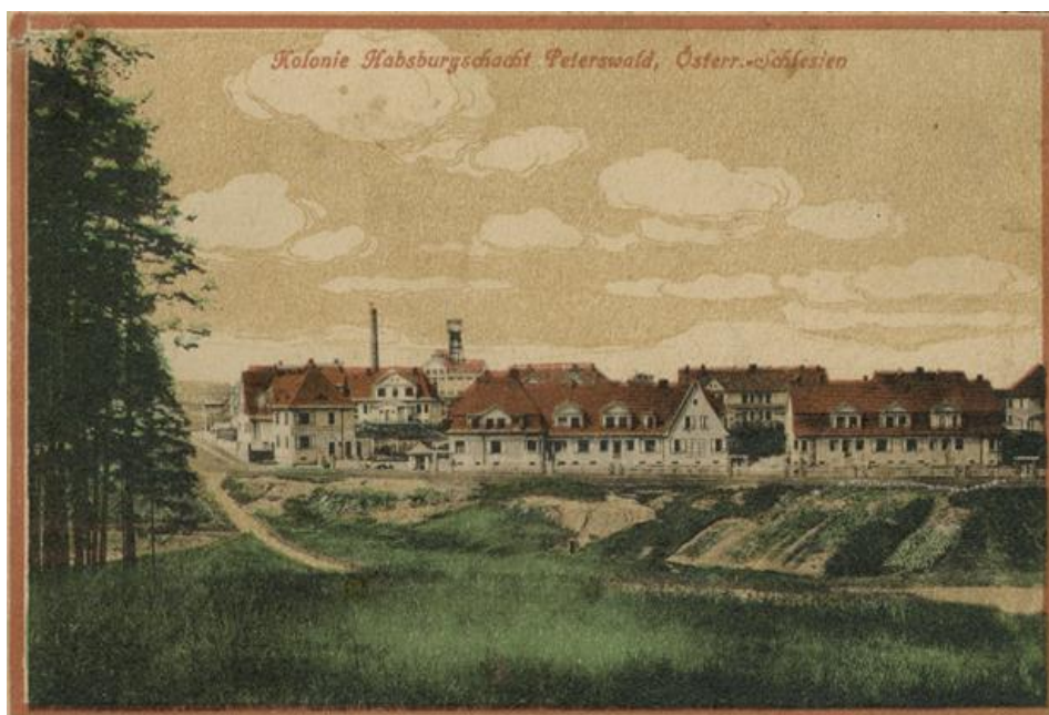
Pohled z východu na kolonii Pokrok (lesní kolonii) v Petřvaldě krátce po dokončení v roce 1914 (Zdroj: Muzeum Těšínska)
