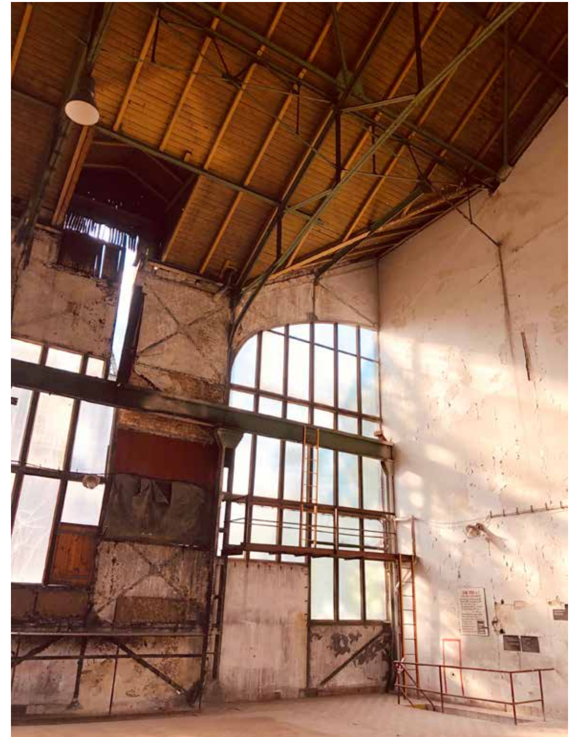
Halový prostor a velín – interiér strojovny dolu Gabriela (zdroj: archiv Jany Šustrové, 2019)
