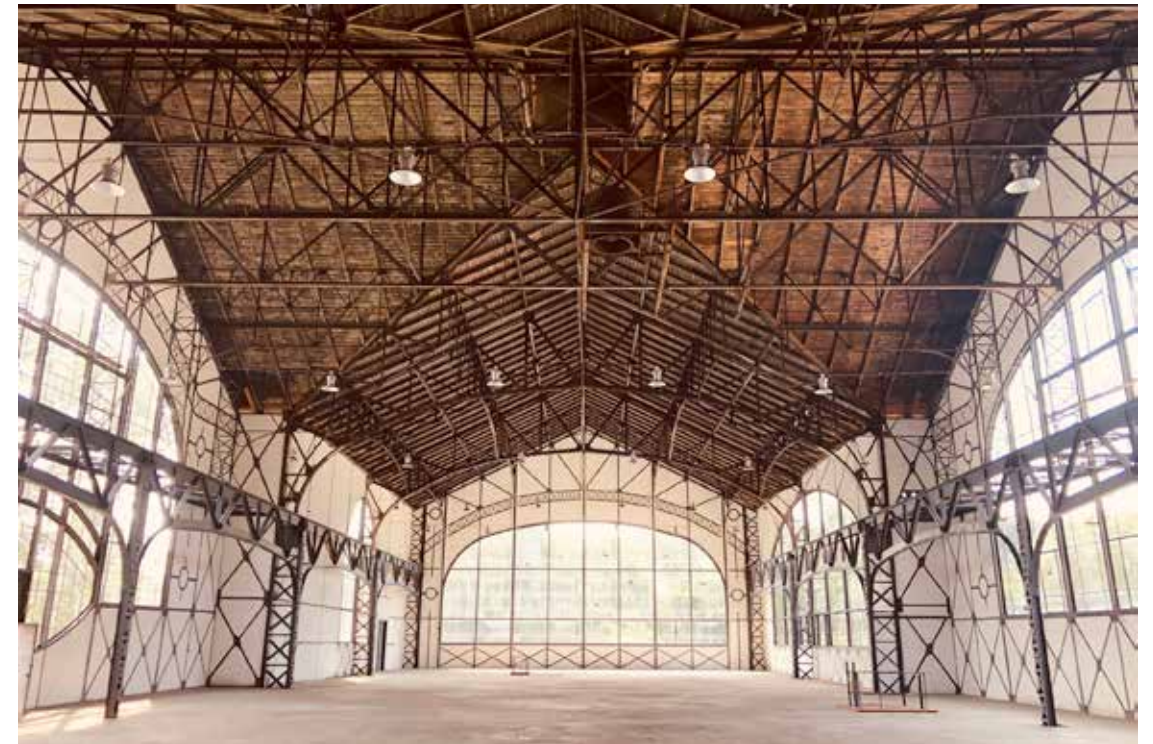
Interiér halového prostoru kompresorovny dolu Barbora (zdroj: archiv Kláry Palánové, 2019)
