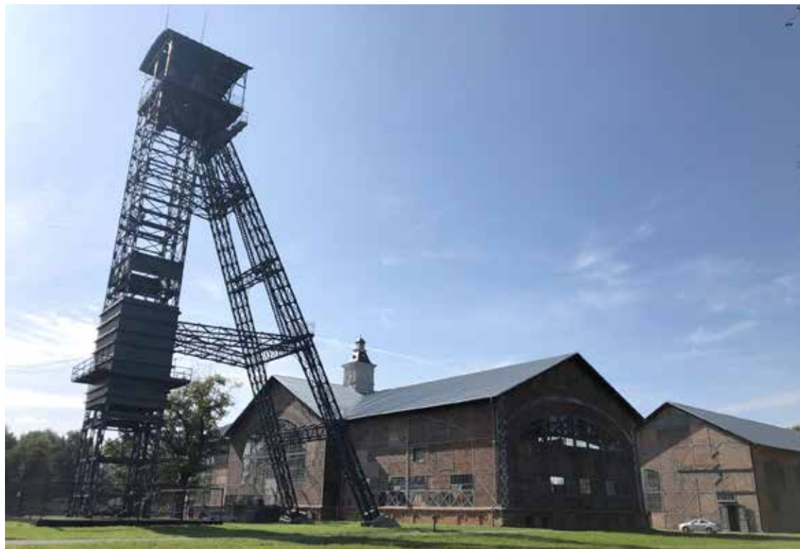
Těžní věž, kompresorovna a strojovna dolu Barbora (zdroj: archiv Kláry Palánové, 2019)
