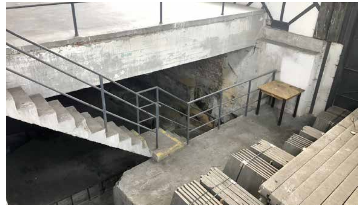
Schodiště do suterénu, důl Barbora, kompresorovna (zdroj: archiv Kláry Palánové, 2019)
