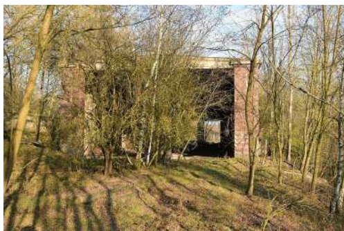
Obr. 3.: Pozůstatky jediné budovy Elektrárny Ervěnice, autor Petr Kinšt, 2014 (Zdroj: https://commons.wikimedia.org/wiki/File:Ervc4%9B-nick%C3%A1_elektr%C3%A1rna_2024_-_11_-_16_Budova_1.jpg , použito dle licence CC BY 4.0)
