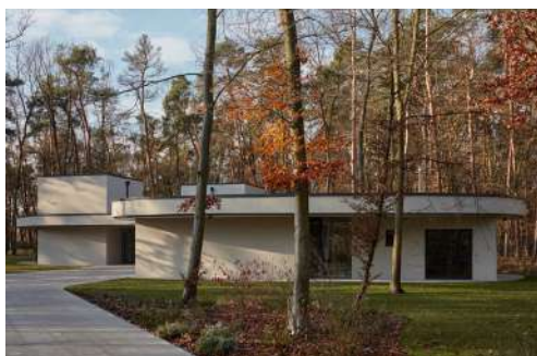
Obr. 9.: Lesní vila, pohled na dům v krajině (Zdroj: https://www.archiweb.cz/b/lesni-vila )
