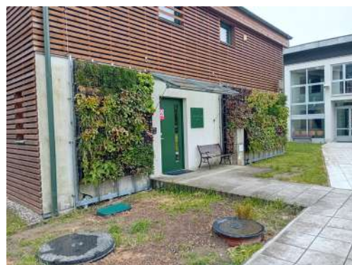
Obr. 3.: Výukový interaktivní model – zelená fasáda a retenční nádrž na dešťovou vodu (zdroj: foto autor)
