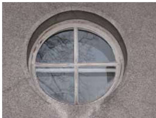
Obr. 8: Spolkový dom Živena, funkcionalistické kruhové okno s pôvodnou výplňou na bočnej fasáde schodiskového rizalitu. (Zdroj: M. Kvasnicová)
