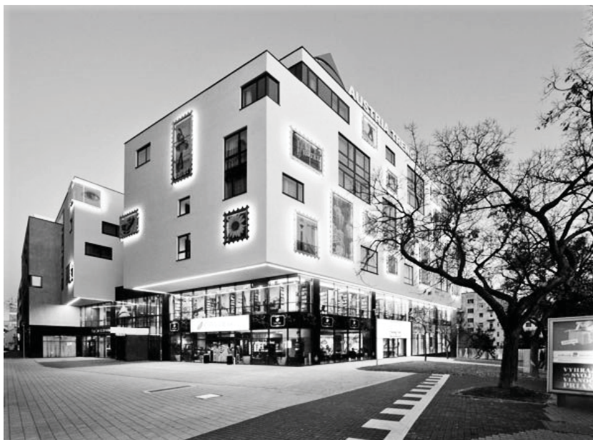
Obr. 5.: Polyfunkčný verejný parter, Austria Trend Hotel, Bratislava (Zdroj: www.asb.sk/architektura/stavby/hotely-a-nakupne-centra/hotel-sjasnym-poznavacim-znamenim )
