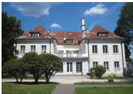
Obr. 2: Zadná fasáda vily s terasou orientovanou do záhrady. (Zdroj: M. Kvasnicová, august 2018)
