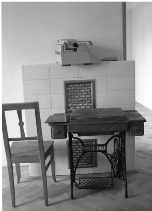
Obr. 9.: Detail vykurovacieho systému, vila Bárdošova 1 (Foto: E. Borecká)
