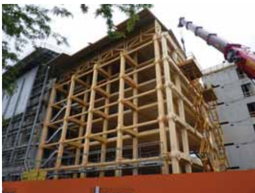
Obr. 3: Nosná konstrukce objektu při výstavbě ( https://www.tamedia.ch/en/group/new-building )
