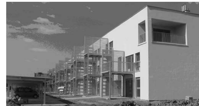
Fot. Elewacja północna, elewacja południowa
