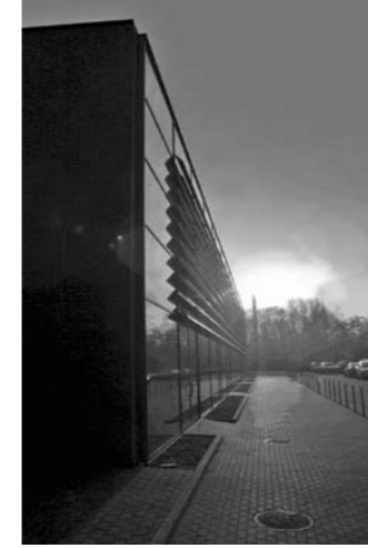
Pic.:10 Technopark side elevation
