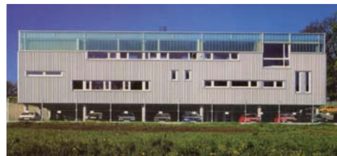
Výhra-administrativní a provozní budova fa Liftcomp v Ostravě (2003-2004), dům roku 2004 statutárního města Ostravy.
