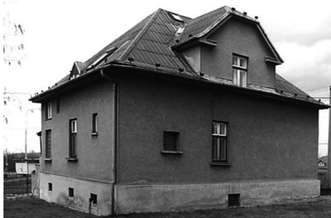
4/ FEBE TRADE – rekonstrukce vily na sídlo firmy - původní stav
