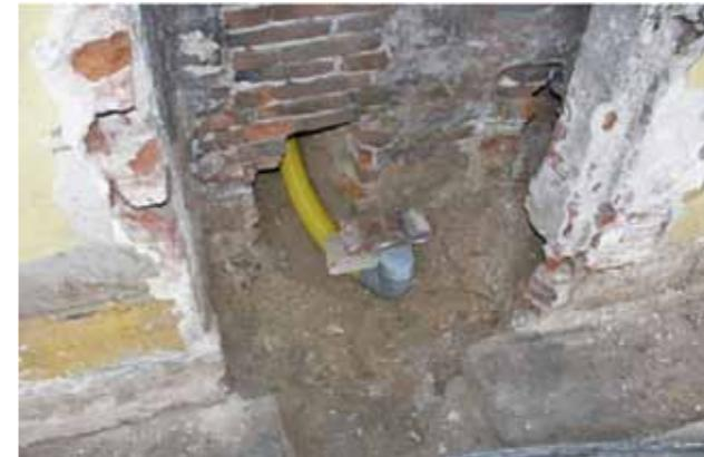
Obr. 6. zaústění odvětrávacího vysoušecího systému do komínových průduchů
