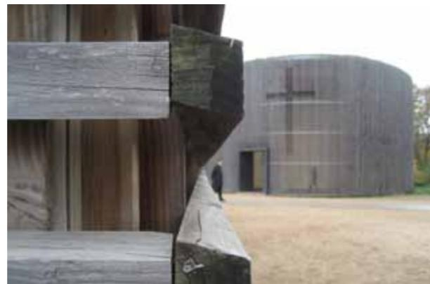
Obr. 7. Kaple Smíření v Berlíně - druhý „plášt“ z dřevěných lamel.
