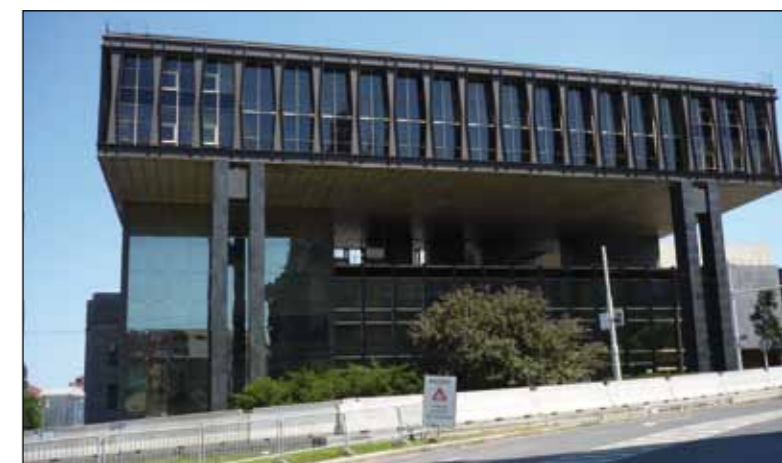
Obr. 10. Budova Svobodné Evropy v betonových zátarasech
