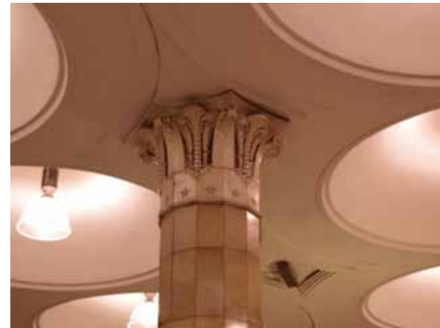
obr. 13. Příklad zachované původní výzdoby metra
