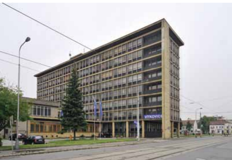
Oskar Olár – Lubomír Šlapeta, Hutní projekt Praha, kancelářská budova – Nové ředitelství Vítkovických železáren, Ruská ul., Ostrava-Vitkovice, 1959–1965, (foto Roman Polášek, 2009)
