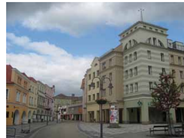
Obr. 6: současná přestavba obchodního domu z roku 2012, foto Peřínková M.
