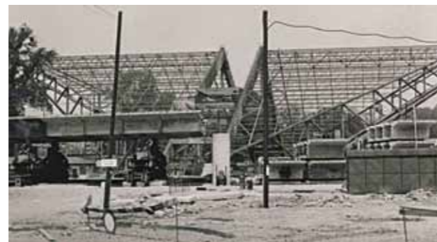
Obr. 3: Ocelová konstrukce haly ve Frýdku – Místku, 1978
