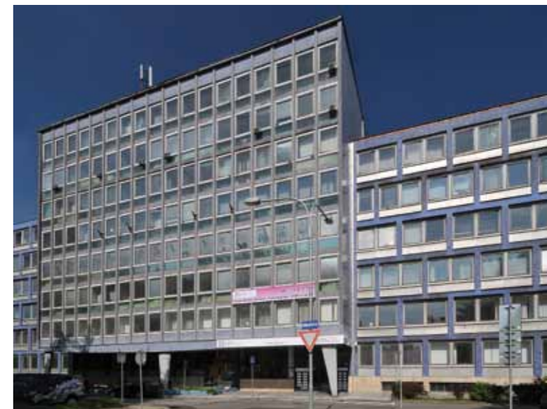
Libor Špaček, kancelářská budova VOKD, Gregorova ul., Ostrava, 1960?–1965?, (foto Roman Polášek, 2009)
