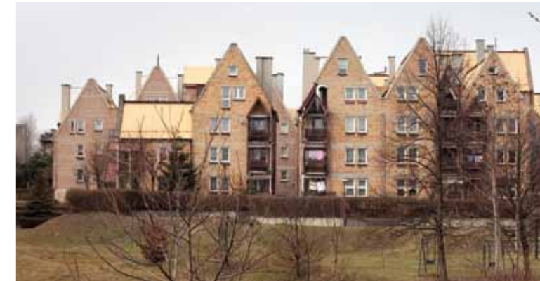
Fig. 6. Housing Estate Waryńskiego in Mikołów Architects: Stanisław Niemczyk, Marek Kuszewski, Jacek Hajkowski, Anna Kuszewska. (Phot. Dorota Zyguła.)
