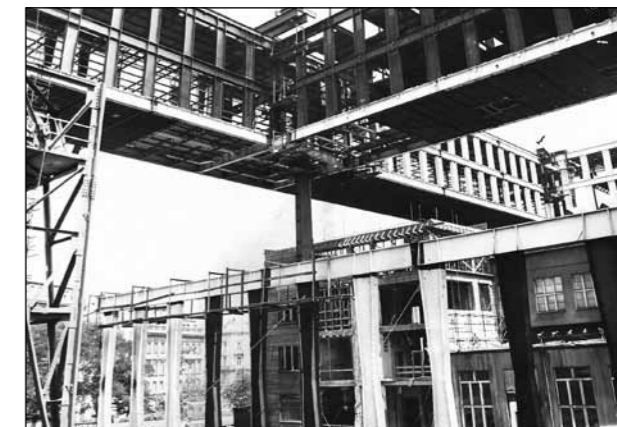
Obr. 9. Z výstavby konstrukce (3)
