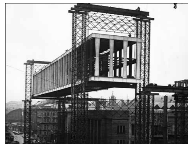
Obr. 8. Z výstavby konstrukce (2)
