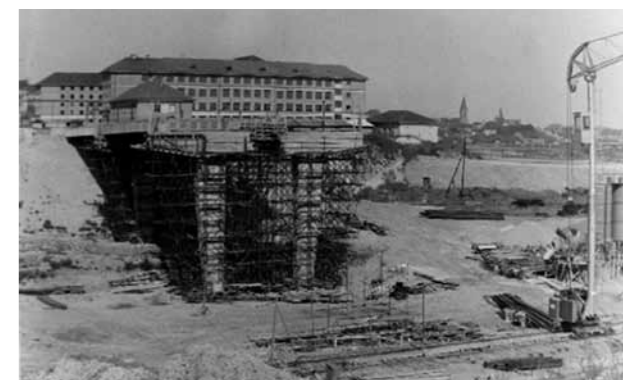
Obr. 11: Výstavba sítenského mostu
