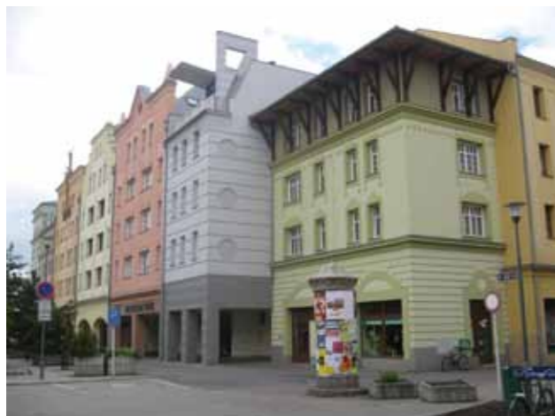
Obr. 7: současná přestavba obchodního domu z roku 2012, foto Peřínková M.
