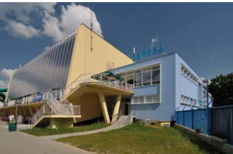
Jan Chválek, Stavoprojekt Ostrava, městské lázně, Sokolská třída, Ostrava, 1957–1963, dílčí přestavby od r. 2001 a celková rekonstrukce 2008–2009 (foto Roman Polášek, 2009)
