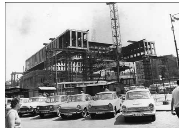
Obr. 7. Z výstavby konstrukce (1)
