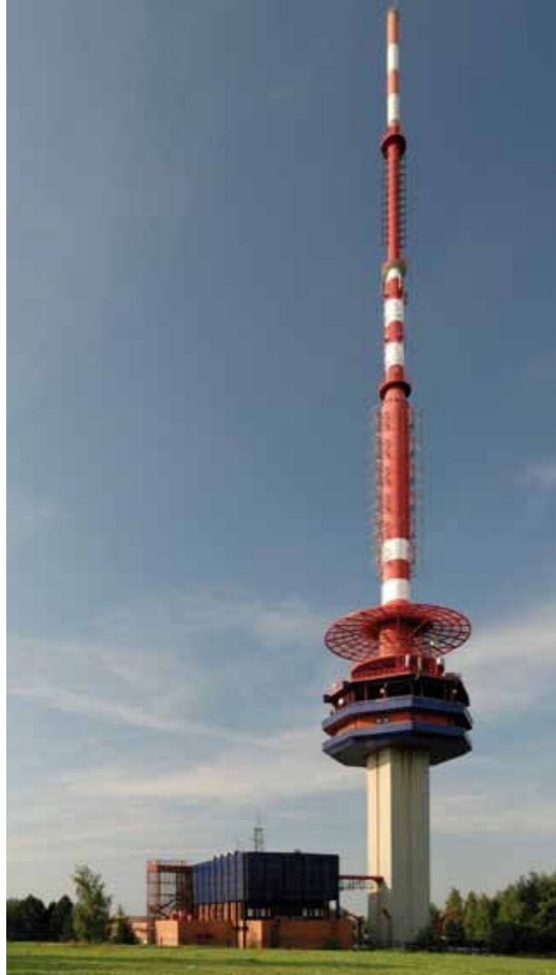
Václav Aulický, spolupráce Antonín Kozák a Jiří Bradáč, Spojprojekt Praha, televizní vysílač, Ostrava-Hošťálkovice, 1976–1979, foto Roman Polášek, 2009
