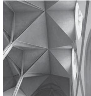
Obr. 9.: Presbytérium kostola Sv. Foillana v Aachene rekonštruovaný v rokoch 1956–1958, zaklenutý železobetónovým lomenicovým stropom na pilieroch. Architekt Leo Hugot. Foto: Jiří Palacký, 2014.
