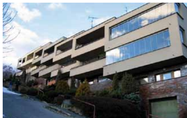
Řadové domy na ulici Příkrá (D. Bílek)
