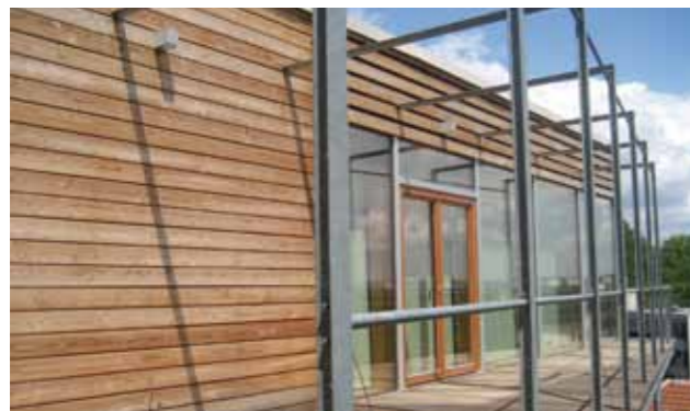
Obr. 7,8. Jihovýchodní obvodová stěna s velkou prosklenou plochou s trojitým zasklením U=0,70 \text{ W}/(\text{m}^2\text{K}) pro zachycení maxima slunečního záření. Pro letní zclonění slouží roleta a pergola s popínavou zelení. Severní fasáda je méně prosklená a účinně zateplená.
