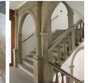
Schodiště zámku v Klimkovicích, foto, 2006
