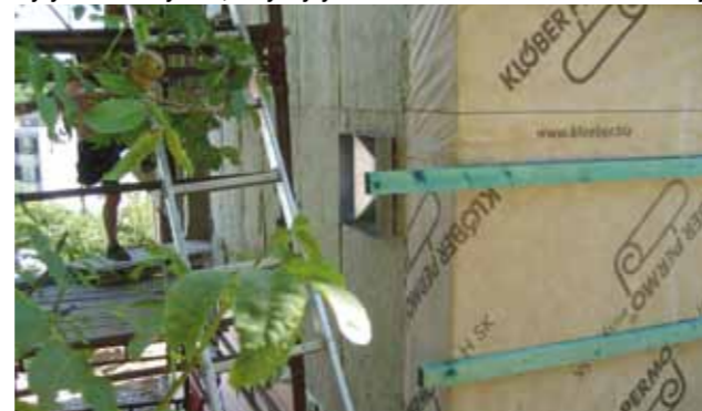
Obr. 5,6. Dřevěná konstrukce (technologie Bova-nail) s pečlivě provedenou izolací Rockwool obvodové stěny tl. 35cm.
