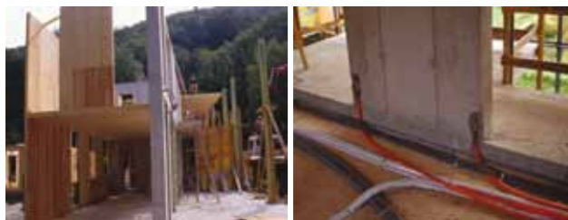
Obr. Betonové jádro a dřevěný deskový systém (cross laminated timber plate), pasivní chlazení aktivací betonového jádra, srovnání potřeby energie různých variant provedení budovy při dispozici 13 m 3 dřeva za rok na otop (červená čára)
