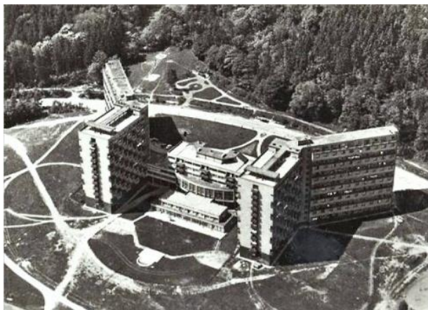
Obr. č. 4 Litvínov – pohled na objekt kolektivního domu
