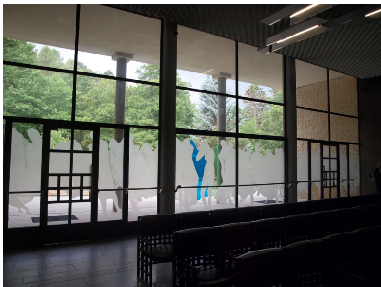
Obr. 5: Krematorium v Motole: spouštěcí prosklená stěna v obřadní síni (zdroj: fotografie autorů)
