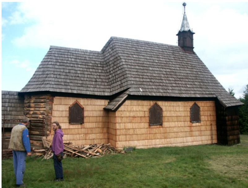
Obrázek 39 Vyšší Lhoty, kostel sv. Antonína Paduánského na hoře Prašivá. Roubená konstrukce je překryta vnějším pláštěm z šindelů. Foto M. Bartošová, 2004.
