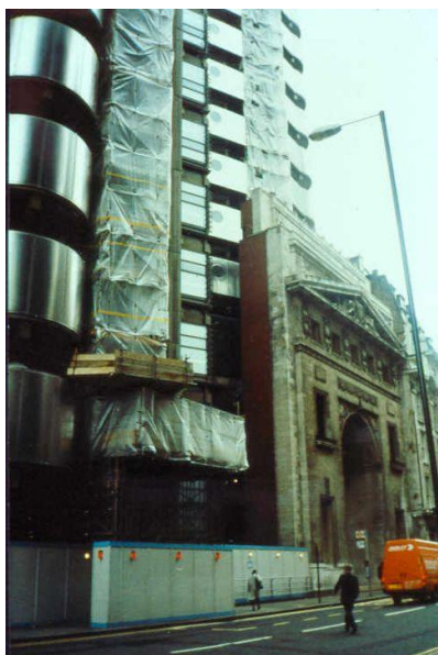
Obrázek 54 začlenění budovy pojišťovny Loyd's v Londýně, Richard Rogers partnership, foto Peřínková M.
