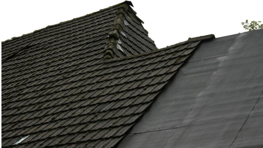
Obrázek 24 Odry, věznice čp. 83 má střechu krytou různorodými novodobými materiály – cementovými taškami, skleněnými taškami a asfaltovou lepenkou. Augustinová, L.: Takzvaná Katovna (čp. 83) v Odrách. POODŘÍ, roč. 12, 1/2009, s. 27 – 34.
