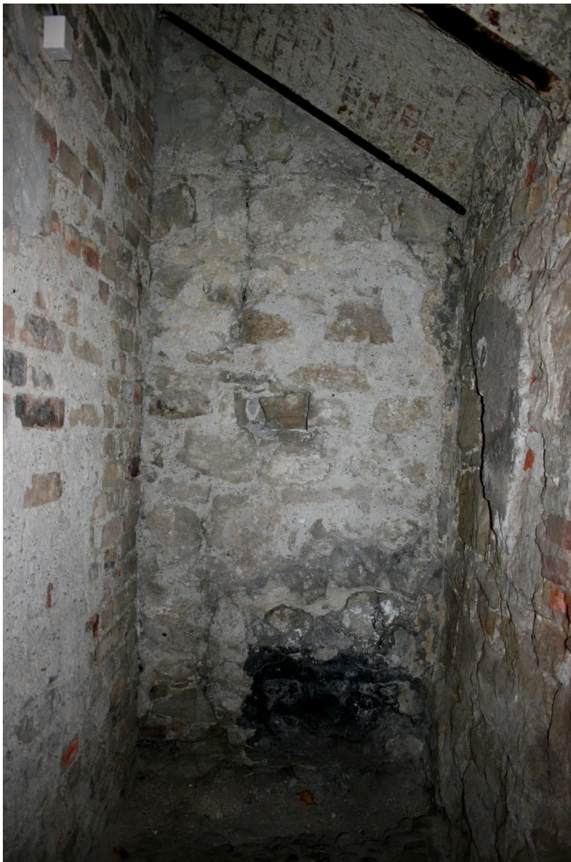
Obrázek 20 Slezskostravský hrad, místnost v bráně dodatečně na počátku 20. století překlenují segmentovou klenbou do travers. Augustinová, L.: Slezskostravský hrad – severovýchodní brána a místnost jádra. Nálezová zpráva. Ostrava 2007.
