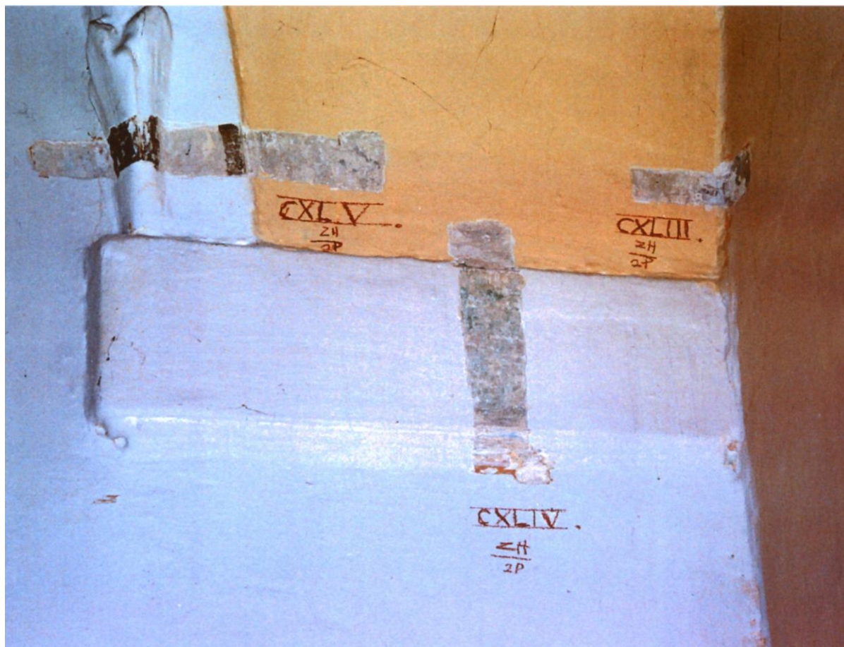
Obrázek 35 Zámek Hlučín, restaurátorské sondy k určení barevnosti interiérové výmalby. B. Valchařová, restaurátorský průzkum zámku v Hlučíně. Opava 2003.
