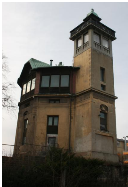
Obrázek 40 Vodárna na Slezské Ostravě, horní patro budovy je vyzděno jako nepravé hrázdění – nosné jsou zde cihlové pilířky a dřevěné výplně jsou vloženy mezi ně. Foto Augustinová, 2009.
