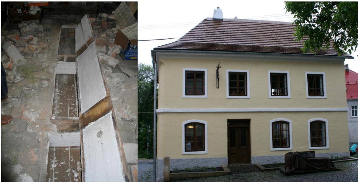
Obrázek 22 Příbor, dům č.p. 117, strop otevřený sejmutím zákloповé desky a Vpravo stav domu po památkové obnově v roce 2006. Augustinová, L.: Nálezová zpráva k rodnému domu S. Freuda Zámečnická 117. Ostrava 2007.
