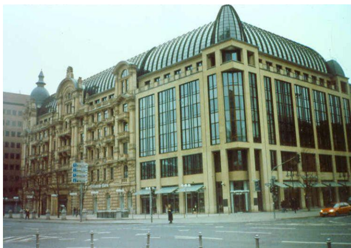
Obrázek 69 dostavba banky ve Frankfurtu n./M., foto Peřinková M.
