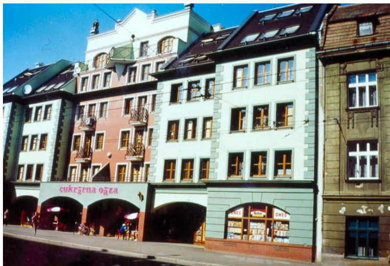
Obrázek 92 dům s malometrážními byty na Krnovské ulici v Opavě, foto Peřínková M.
