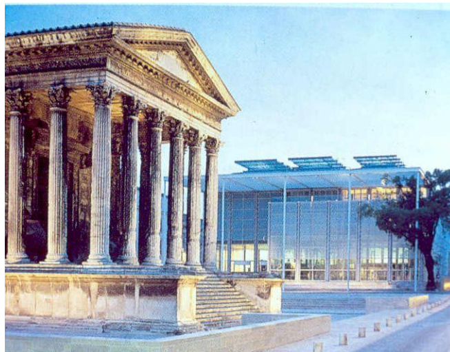
Obrázek 64 kulturní centrum Carré d'Art v Nîmes, Norman Foster. Aula, kinosál a obchod jsou zapuštěny, Franz Pesch, Neues Baunen in historischer Umgebung
