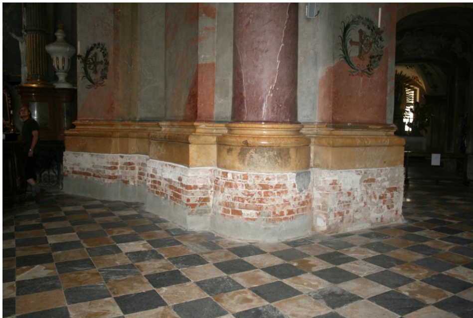
Obrázek 23 Rajhradský klášter, vizuálně patrná materiálová skladba – kamenné dlaždice, cihlový sokl svazkového pilíře a umělý mramor použitý jako obklad dřívku. Foto Augustinová, 2006.
