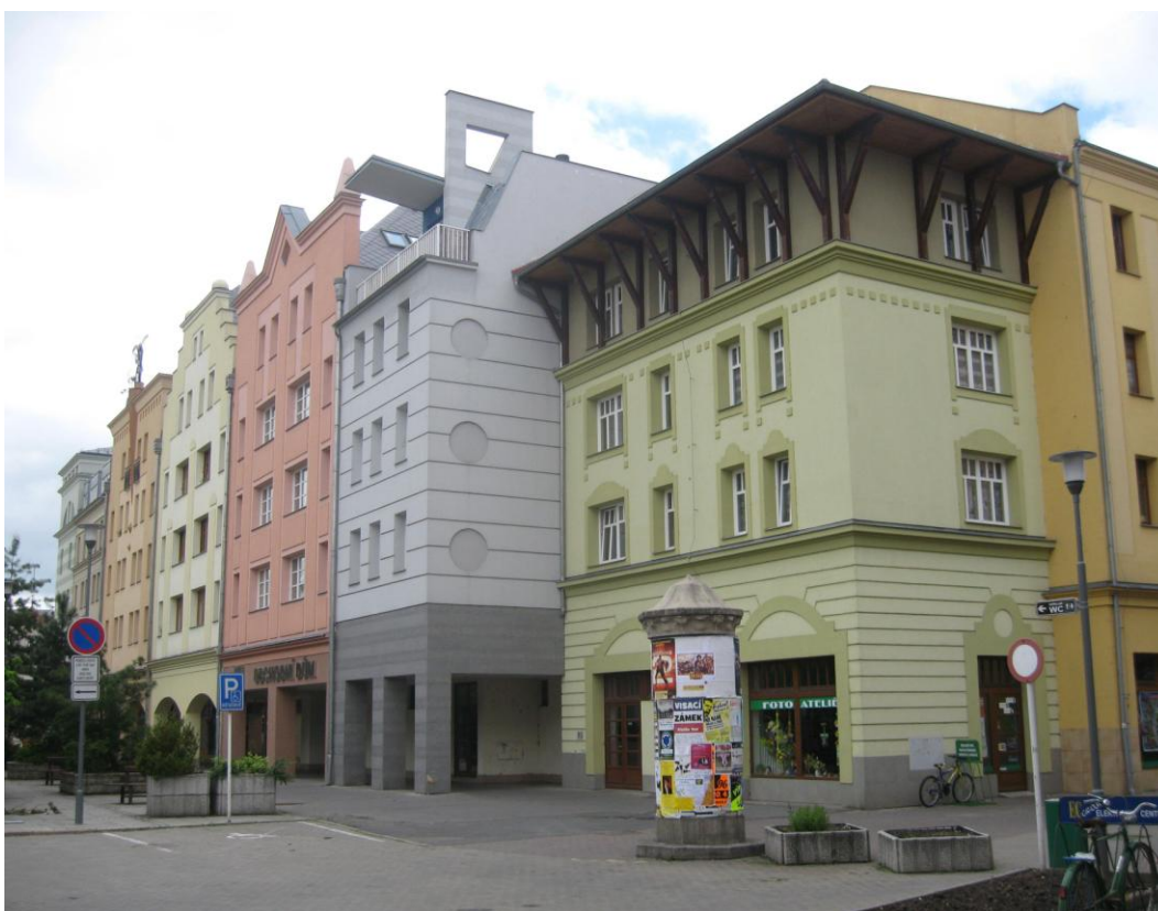
Obr. 112: současná přestavba obchodního domu z roku 2009, foto Peřínková M.
