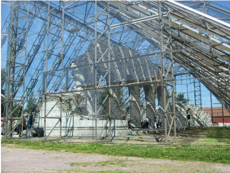
Obrázek 78 pohled na objekt exteriéru, foto Peřínková M.
