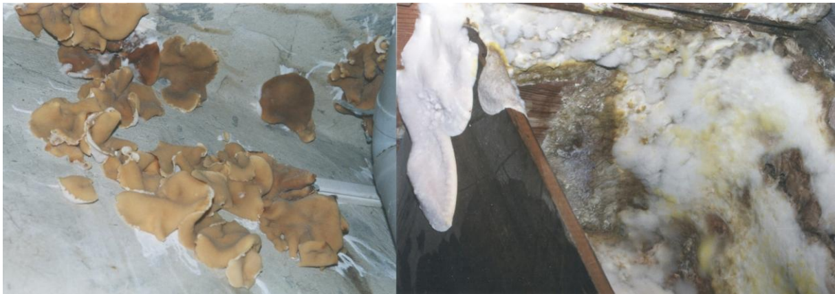
Obrázek 29 Ostrava, Stará radnice v Moravské Ostravě, Vlevo neškodná houba řasnatka zední, vpravo nejnebezpečnější z dřevokazných hub dřevomorka domácí (Serpula Lacrimans). Foto V. Gřondělová, 2003.
