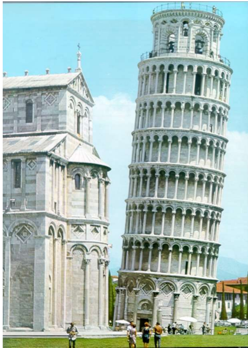
016 * Dóm a věž v Pise (1063 –1278) Sloupkové galerie, dole masivní podnoží se slepými arkádami
