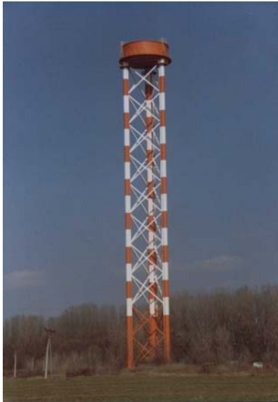
Obr. 1 Pohľad na vežový vodojem
