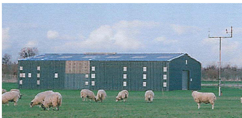
Obr. 1: Silsoe strukturovaná stavba s odběrovými místy
