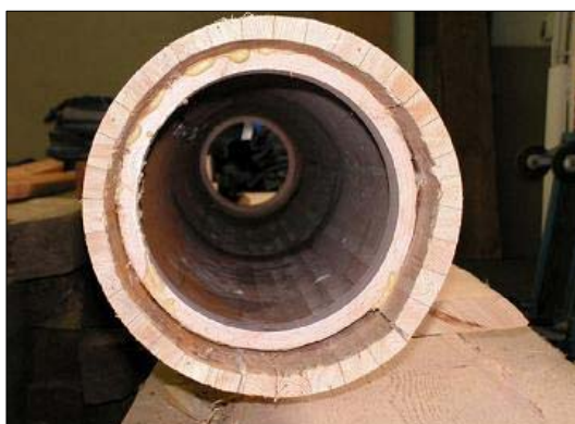
Obr. 1.1 Kruhový průřez sloupu z formovaného dřeva
