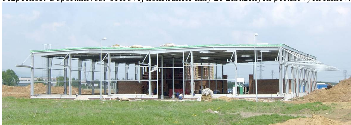
Obr. 1: Nosná konštrukcia oceľovej haly
