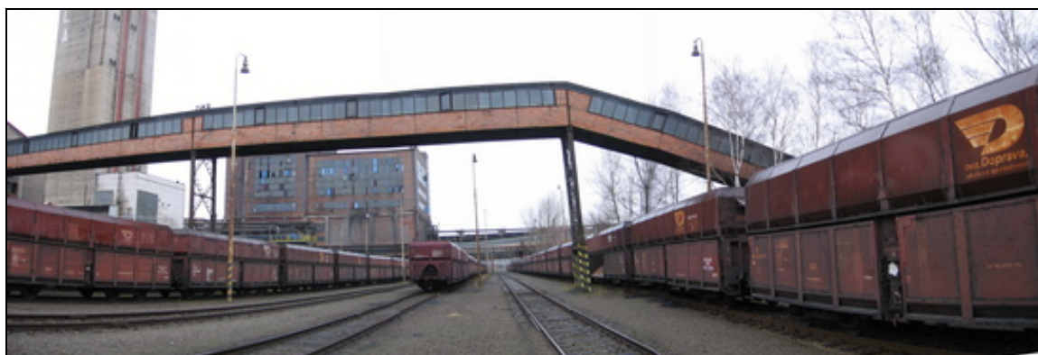
Obr.1: Stávající technologický most pásové dopravy, vlevo těžní věž z litého betonu
