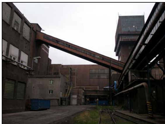
Obr.1: Celkový pohled na konstrukci
