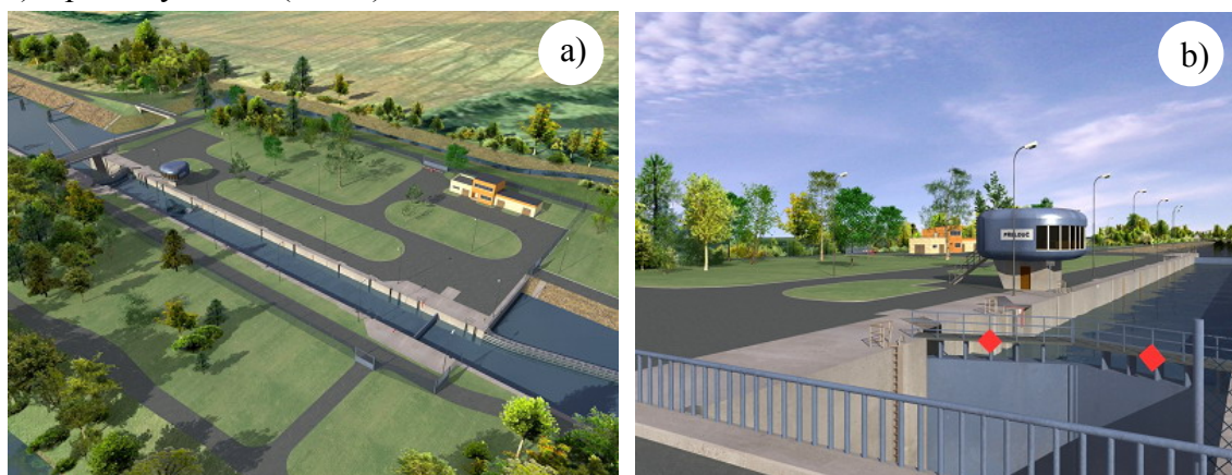
Obr. 1: Pohled na plavební komoru (a), pohled na dolní ohlavi se vzpěrnými vraty (b)
