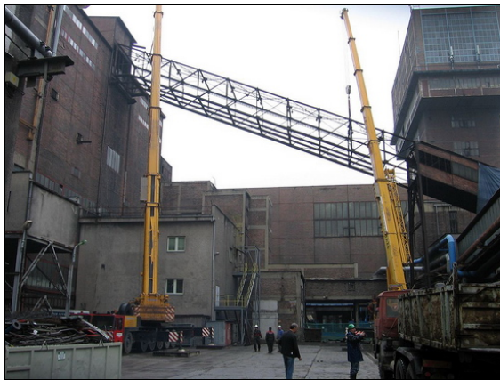
Obr.3: Zavěšení odstojené konstrukce na dva jeřáby
