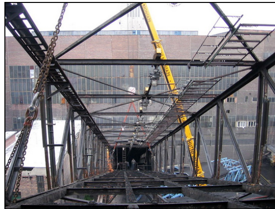
Obr.4: Zavěšení na jeřáb - pohled od nejvyšší podpory
