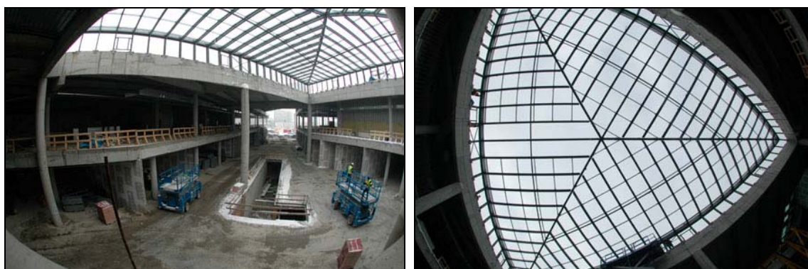
Obr.1 a 2: Celkový pohled na nosnou konstrukci světlíku
