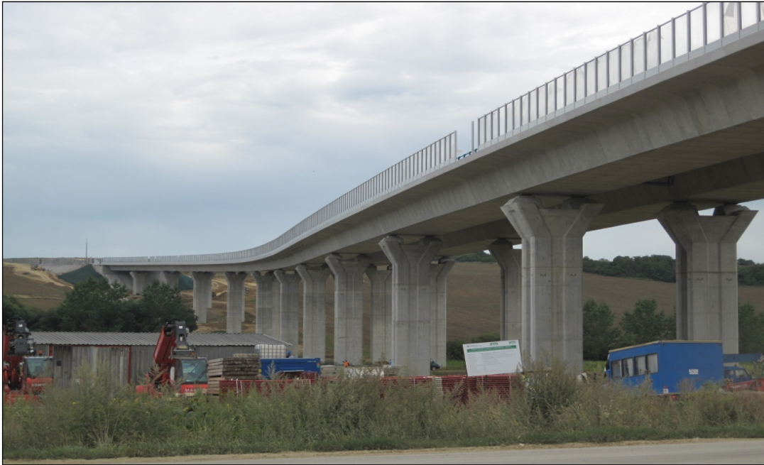
Obr. 1 Pohľad na merané mosty objektu SB 203 úseku Selenec – Beladice na R1.
