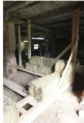
Obr. 1: Vyzázení rohu stěny ze slámového balíku
