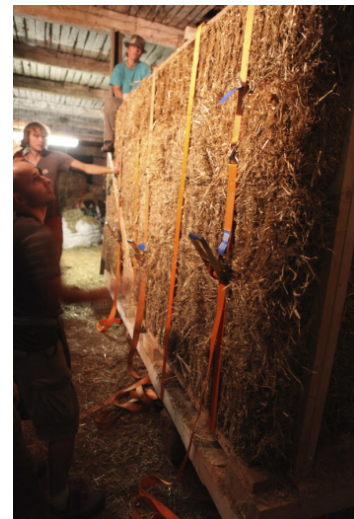
Obr. 2: Předepnutí stěny ze slámového balíku
