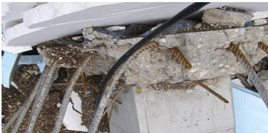
Obr. 2: Charakteristický tvar poruchovej zóny pri pretlačení stĺp - doska
