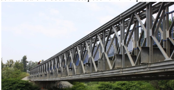
Obr. 1: sledovaná mostní konstrukce MABEY UNIVERSAL
