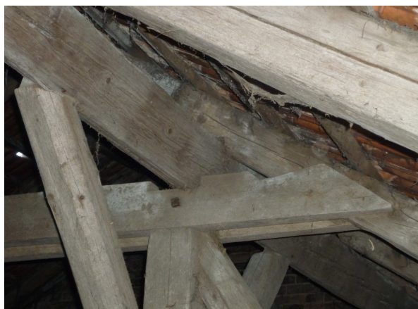
Obr. 2: Detail styku vaznice, sloupku, kleštin a krokve
