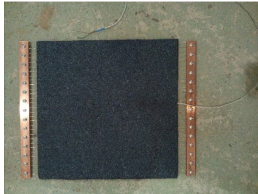
Obr. 1: Odporová mřížka mezi asfaltovými vrstvami
