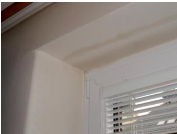
Obr.6 Kontrola netěsností rámců oken a dveří v připojovací nebo funkční spáře.
