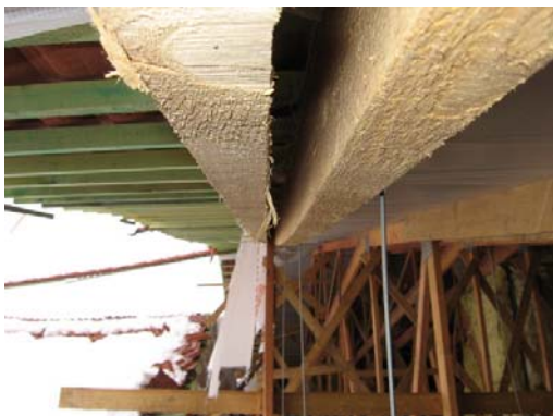
Obr.8 Průhyb jedné z krokví
