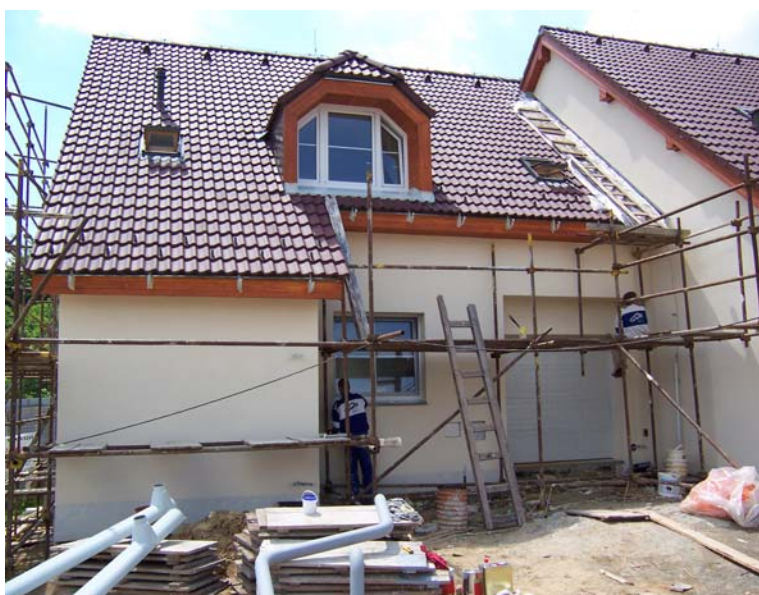
Obr.2 Výstavba řadových domů 1. etapa
