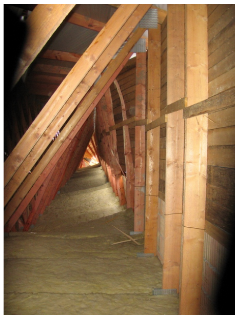
Obr.13 Zajištění proti vybočení na opačné straně bylo zajištěno rovinou dřevěného bednění
