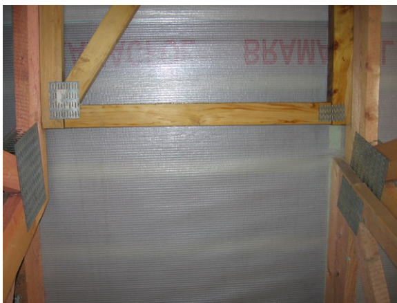
Obr.14 Ztužidlo v rovině střechy
