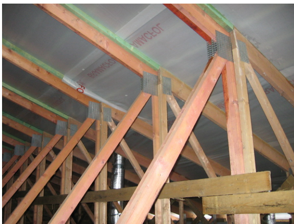
Obr.11 Krajní prut střešního vazníku měl být zajištěn po 60 cm proti vybočení
