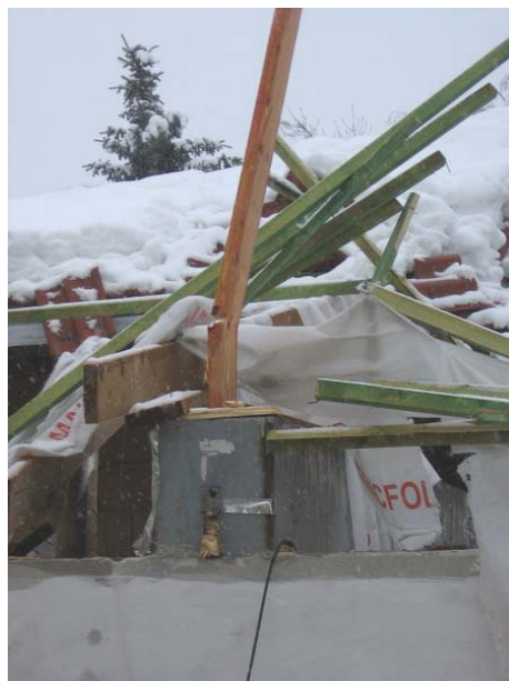
Obr.10 Uložení na střední nosné zdi ve zborcené části
