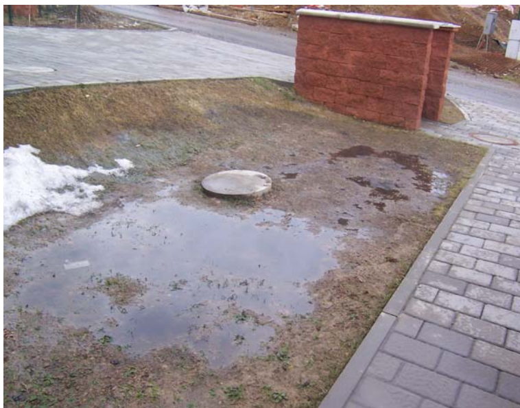
Obr.8 Násypová nepropustná zemina po dešti
