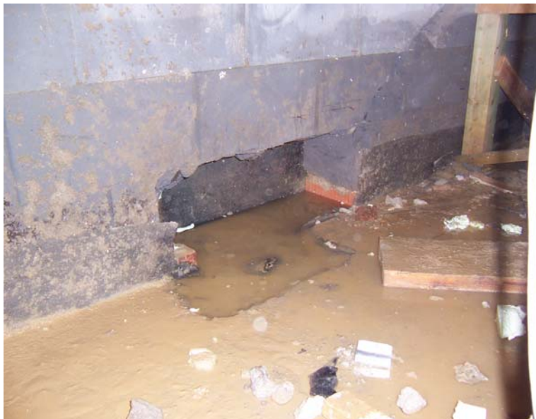
Obr.5 Sonda v plynosilikátovém zdivu
