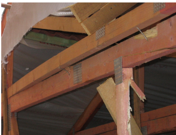
Obr.12 Spojení dolního taženého pásu horní části vazníku s dolním tlačným pásem dolní části vazníku
