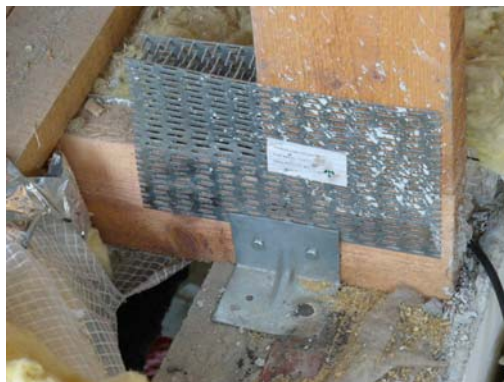
Obr.9 Uložení vazníku na „střední“ zdi v západní oblasti objektu (u pokladen)
