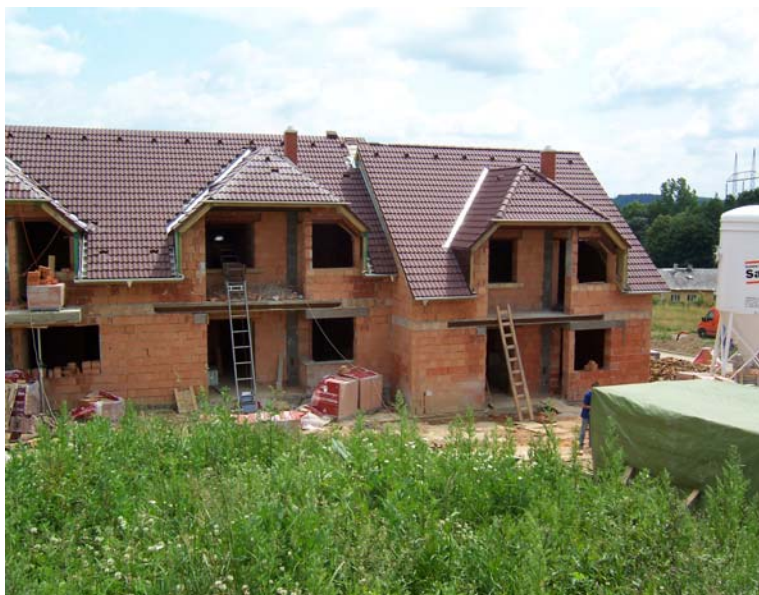
Obr.1 Výstavba řadových domů 1. etapa
