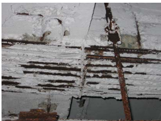
Obr.5: Zcela degradovaná betonová krycí vrstva průvlastku – výztuž silně zkorodovaná.
