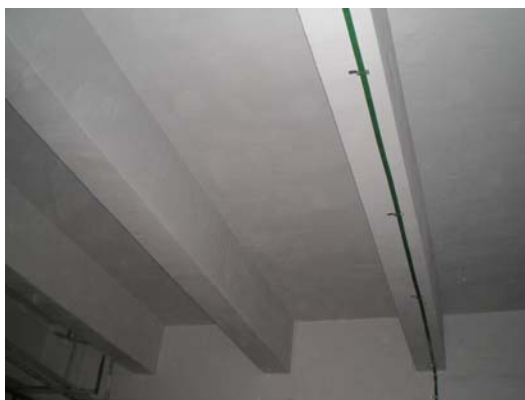
Obr.16: Konstrukce trámového stropu po sanaci
