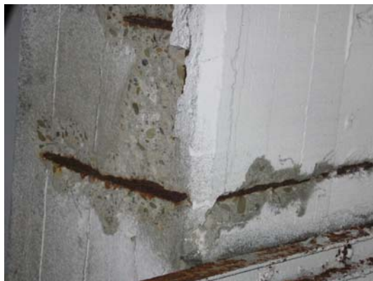
Obr.9: Zcela degradovaná betonová krycí vrstva sloupu v patě – počínající koroze výztuže třmínků.
