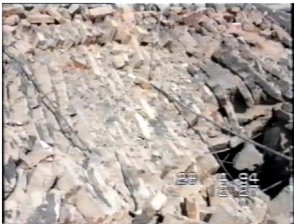
Obr.5: „Položená“ stěna a průraz ve stropě
