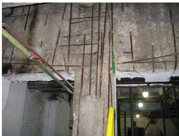
Obr.3: Zcela degradovaný styk sloupu a průvlatu – výztuž je funkční pouze z části.
