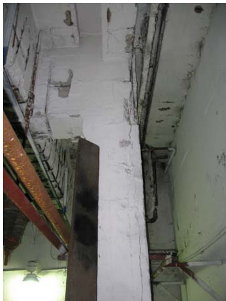
Obr.11: Poškození sloupu přetížením (porušení v podélném směru v rozích sloupu)
