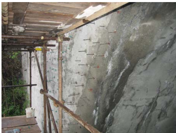
Obr.10: Armovaná injektáž klenby – připravené pruty výztuže
