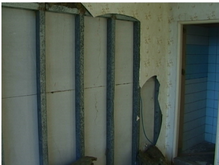
Obr.7: Nosná konstrukce zničených příček
