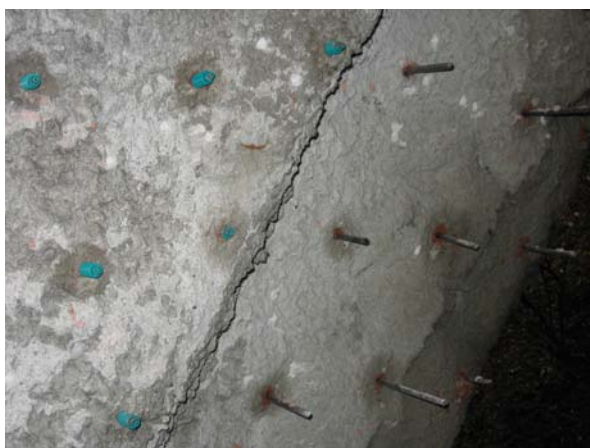
Obr.13: Vlevo pakry pro tlakovou injektáž, vpravo výztuž před nasazením pakrů (vyztužený injektážní vrt.
