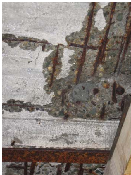
Obr.4: Koroze výztuže desky a koroze válcovaných ocelových nosníků stropů nad suterénem (plošiny)
