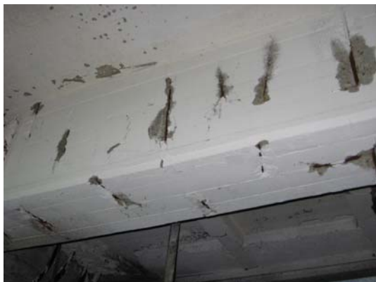
Obr.7: Zcela degradovaná betonová krycí vrstva průvlastku – odlupující se krycí vrstva.
