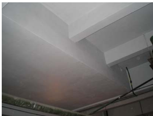
Obr.65: Trámový strop a tlustá deska
