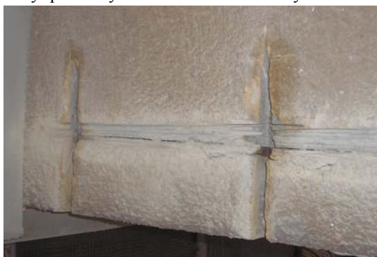
Obr. 4 Vyfrézované drážky
