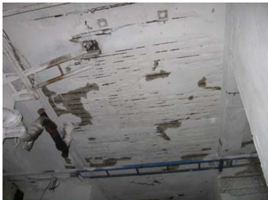
Obr.1: Zcela degradovaná betonová krycí vrstva – výztuž je „chráněna“ vápenným pačokem, je silně zkorodovaná.
