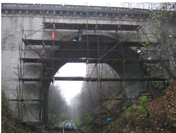
Obr.8: Celkový pohled na most při sanaci
