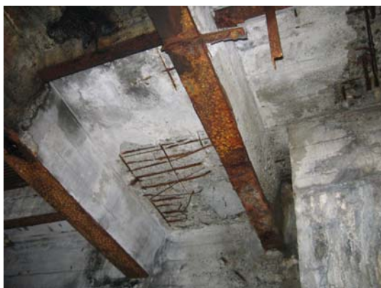
Obr.3: Zcela degradovaná betonová krycí vrstva – výztuž silně zkorodovaná.
