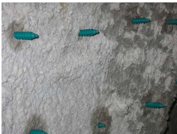
Obr.11: Pakry pro tlakovou injektáž
