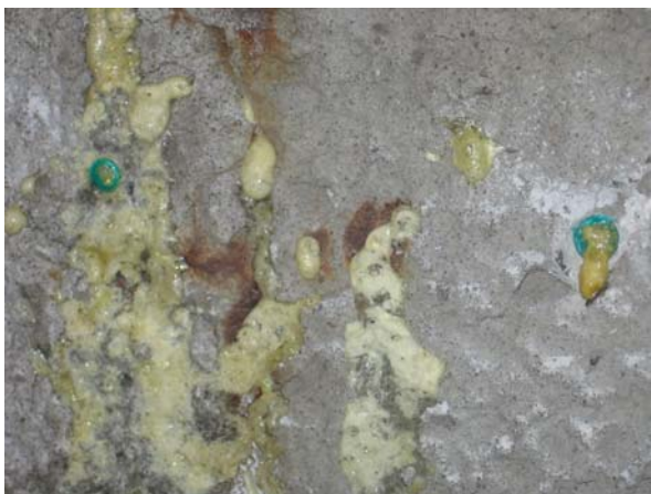
Obr. 9: Povrch po injektáži před zednickou úpravou
