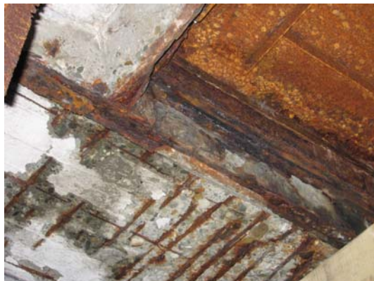
Obr.2: Vysoký stupeň koroze dolní výztuže desky – úbytek vlivem koroze není staticky nezajímavý
