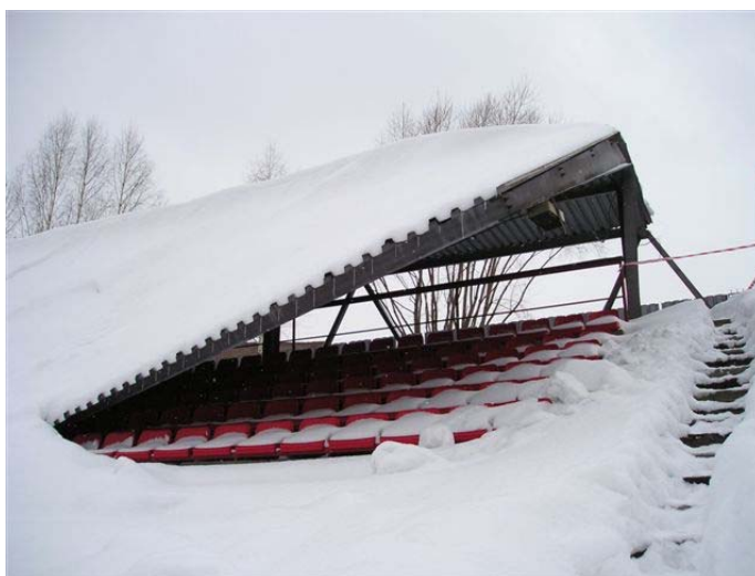
Obr.1 : Havárie tribuny fotbalového stadionu vlivem přetížení sněhem.
