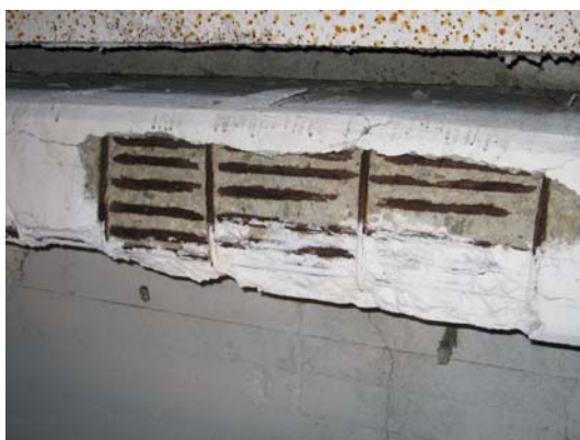
Obr.6: Vysoký stupeň koroze dolní výztuže průvlastku – úbytek vlivem koroze není staticky nezájímavý
