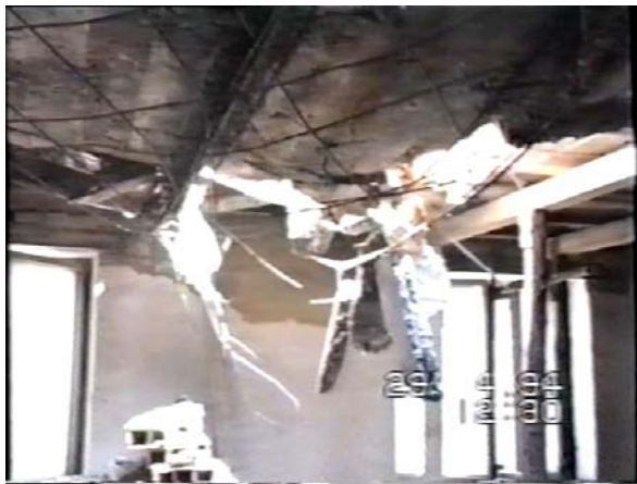
Obr.6: Proražený strop
