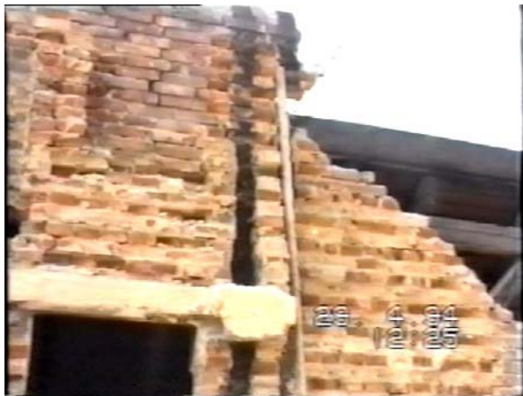
Obr.3: Komůrkové zdivo v okolí dveřního otvoru.
