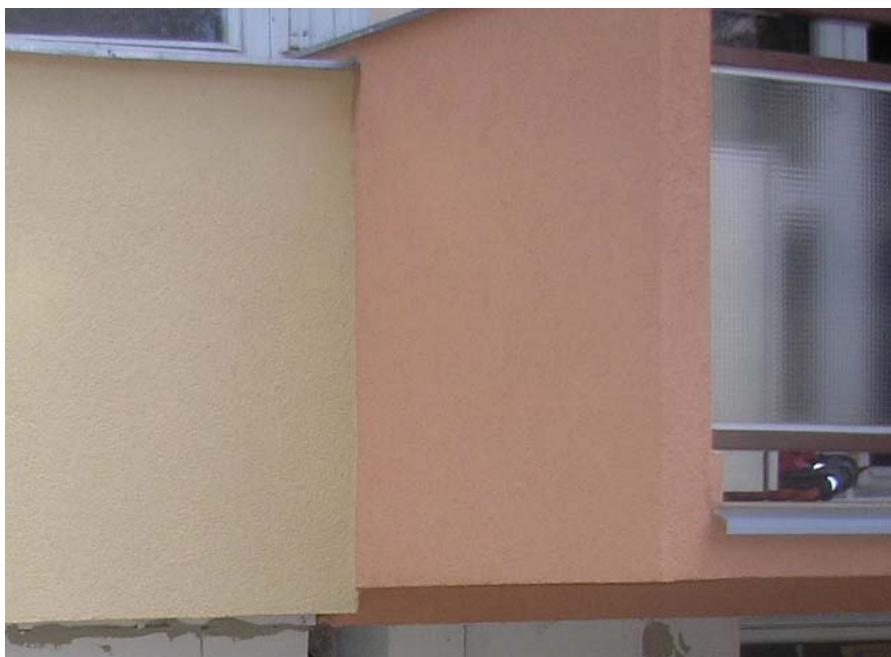
Obr. 6 Konečný stav po sanaci trhliny
