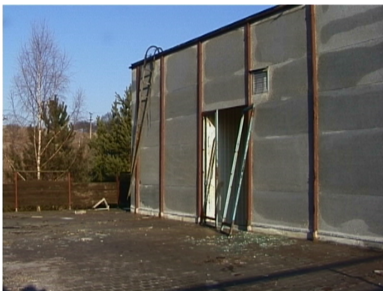
Obr.5: Terasa posledního podlaží ubytovací části
