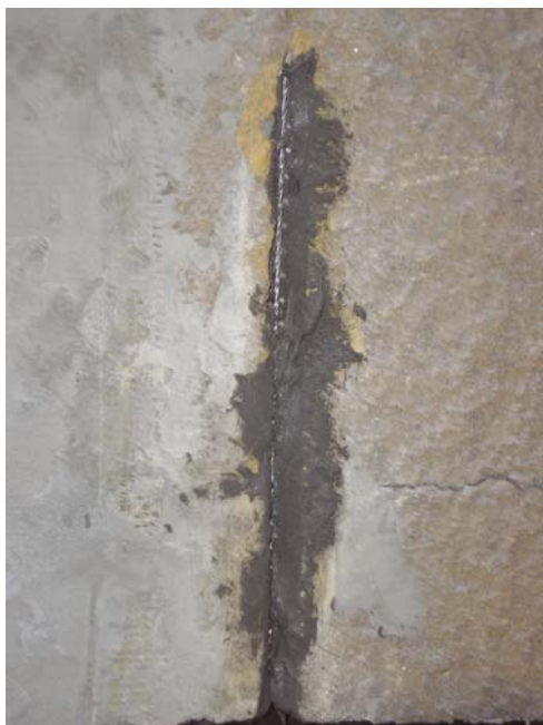
Obr. 5 Vlepená výztuž osazena do drážky
