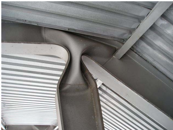
Obr.2 Detail vyboulené stojiny v místě rámového styčnicku tribuny.
