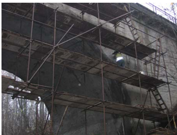
Obr.12: Lešení pro provedení injektáže
