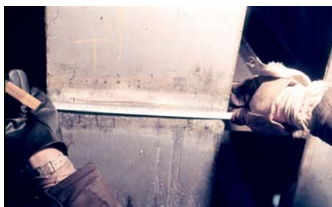
Obr. 11: Zjištěné únavové trhliny nepřípustných délek na dolním pásu.
