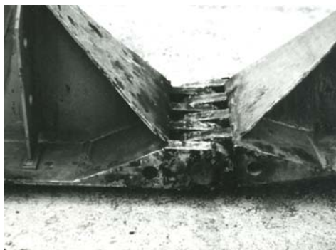
Obr. 4: Čepový styk.
