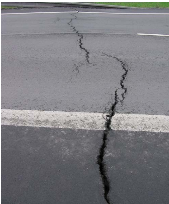
Obr. 4 Projev vlivů poddolování na vozovce v jižní části poklesové kotliny (profil cesta)
