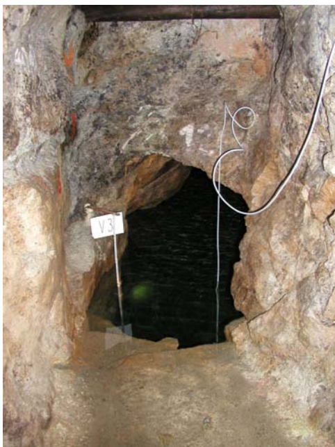
Foto 8 Technická kulturní památka Důl Jeroným v Čisté – měření úrovně hladiny důlních vod
