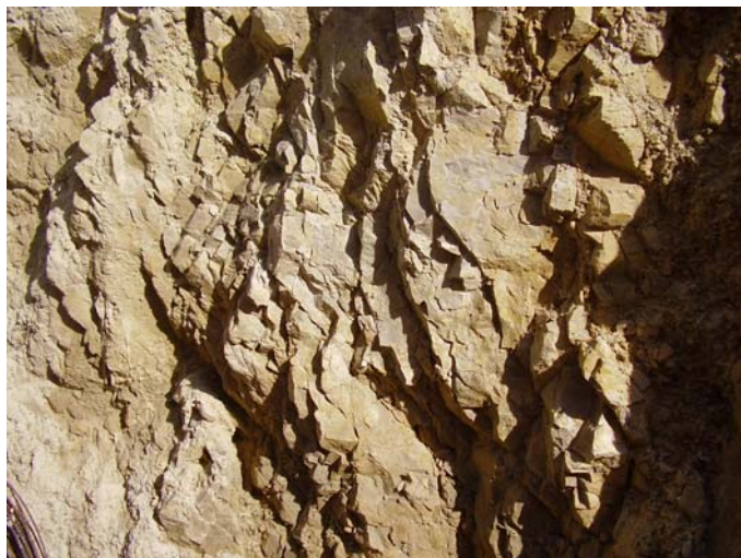
Obr. 3 Dolomit rozložený – odkop stavebnej jamy pred tunelovými rúrami
