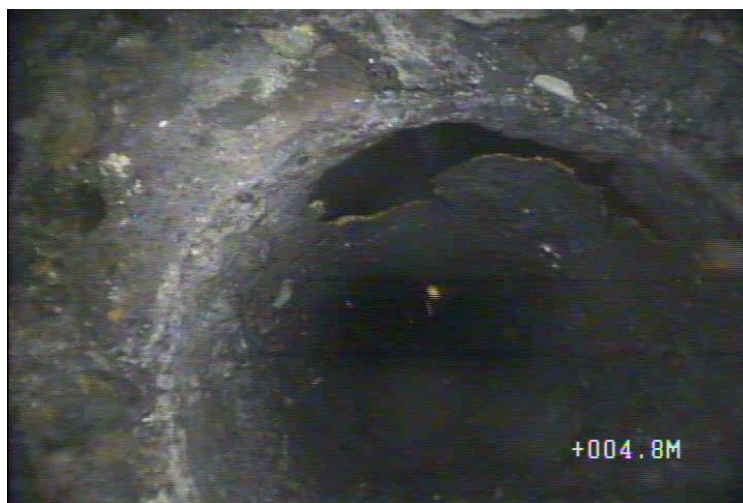
Obr.2 televizní prohlídka starého vrtu před rekonstrukcí- havarijní stav pažnice
