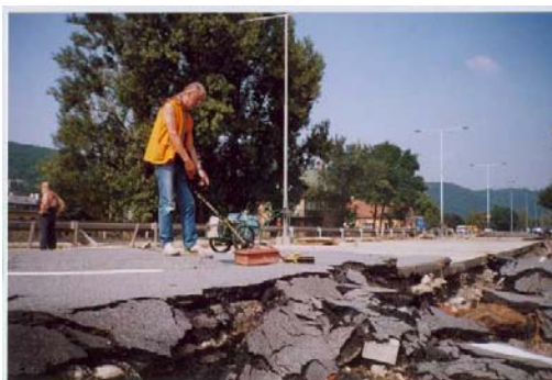
Obr. 1 Georadarový průzkum na komunikaci poškozené povodní
