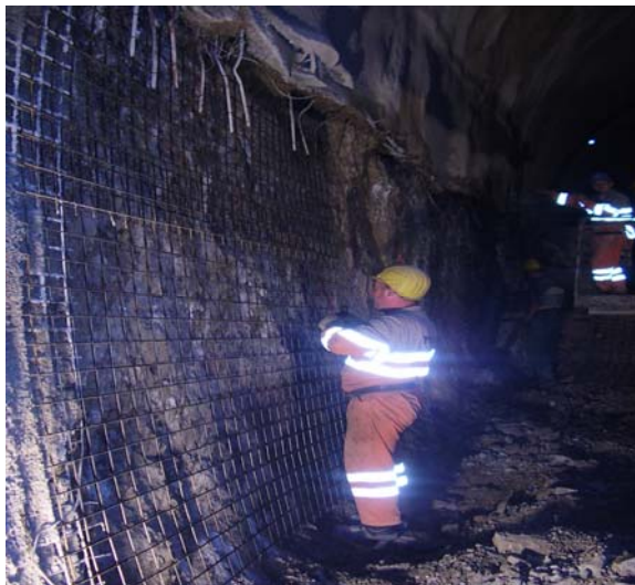
Obr. 2 Vrtanie lavice pre odstrel č. 1- stena pred odstrelom (vľavo) a stena po odstrele (vpravo)
