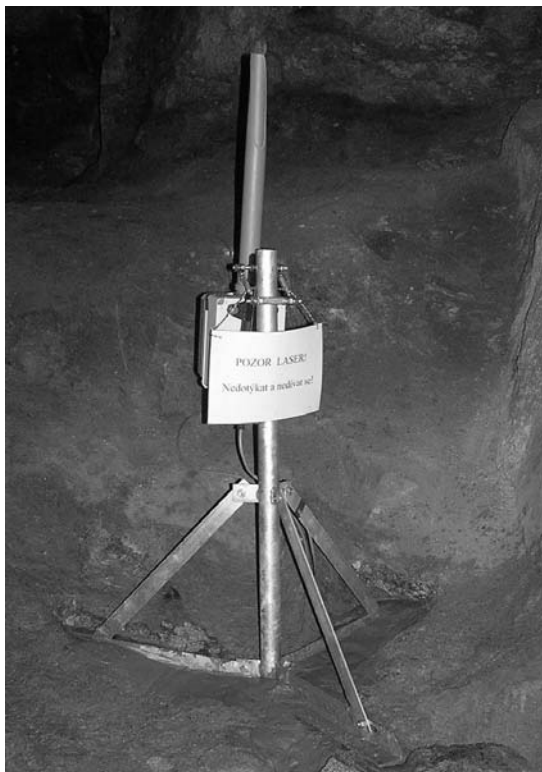
Obr. 4 Instalace LDM v komoře K2
