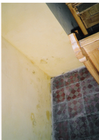
Obr.4: Kondenzace vodní páry na povrchu stěny v blízkosti podlahy (objekt s vysokou tepelnou setrvačností)
