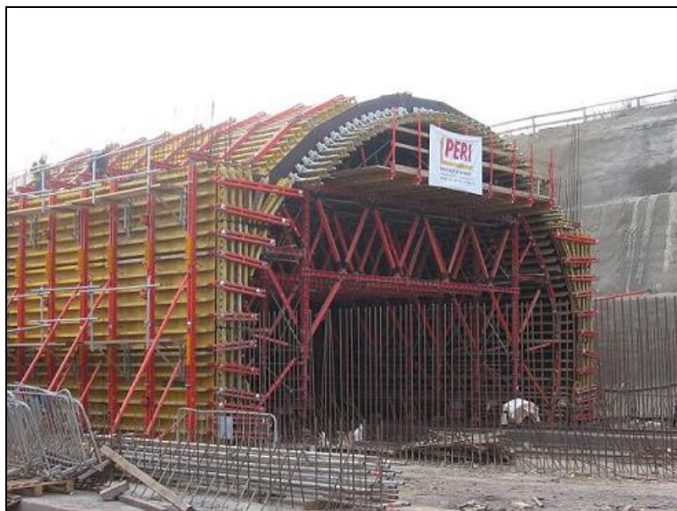
Obr.9: Vnější bednění - záklop PERI (foto PERI s.r.o. ©).
