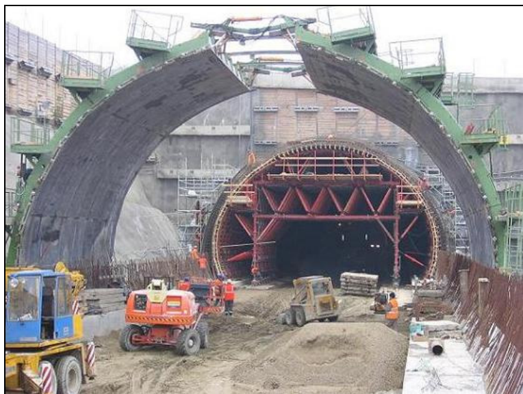
Obr.10: Ocelové vnější bednění – záklop (foto PERI s.r.o. ©).
