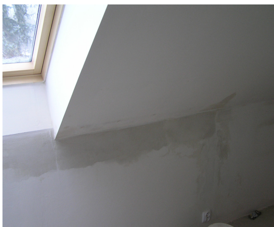
Obr.5: Kondenzace vodní páry v koutě na povrchu stěny a stropu (nedostatečná tepelná izolace obvodové stěny)
