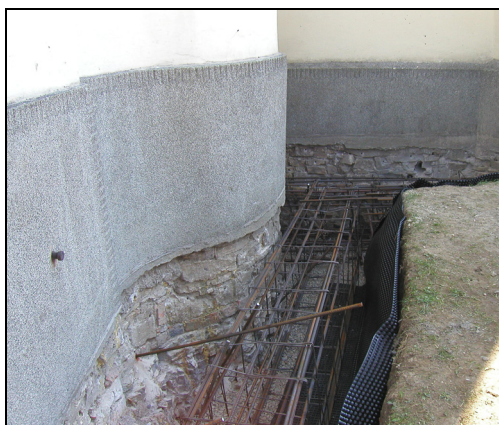
Obr.1: Dodatečné vyztužení základů
