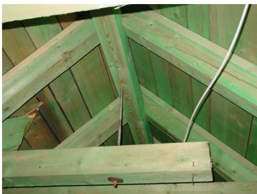
Obr.7: Nevhodné řešení připojení vrcholové vaznice vikýře (nezajištění vodorovného posunu vaznice, deformace vikýře a svorníku)
