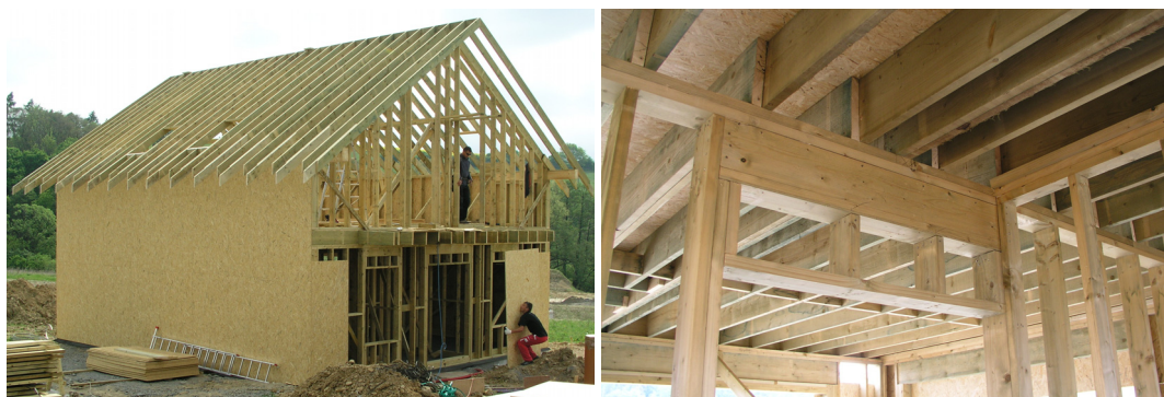
Obr.1: Výstavba rodinného domu – lehký dřevěný skeletový systém
