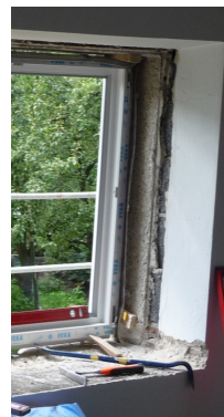
Obr. 4: Aplikace parozábrany
