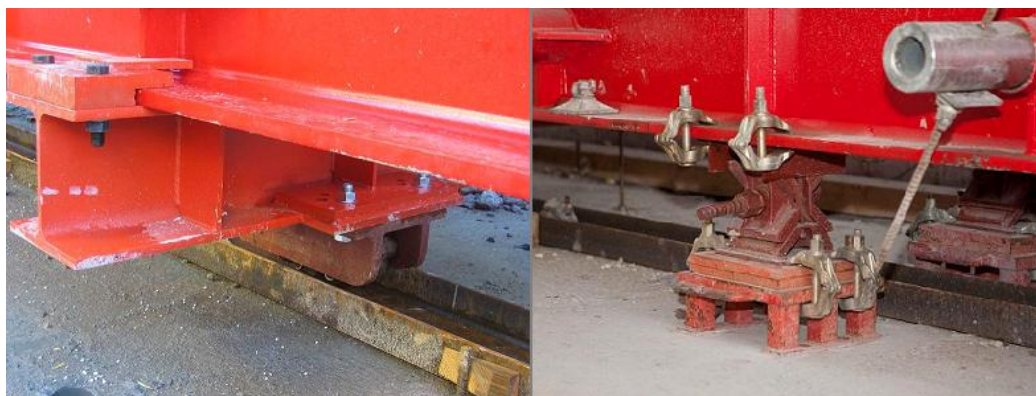
Obr. 10: Pojezdové rolny a stavěcí klíny pod podélným nosníkem (foto PERI s.r.o. ©)
