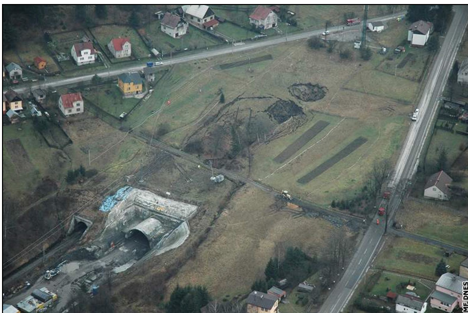
Foto 2. Foto z místa vzniku havárie - vytvoření povrchového kráteru (autor MF Dnes)
