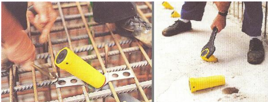
Obr. 7: Montáž kotevního držáku V k hlavní výztuži spodní desky (foto PERI s.r.o. ©)
