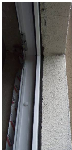
Obr. 1: Osazení výplně za pomoci turbošroubů
