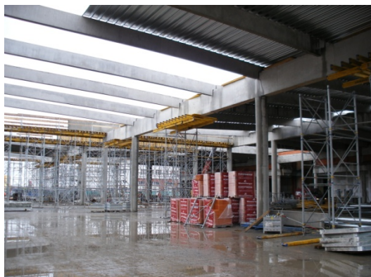
Obr.1: Předpjatá střešní vaznice – umístění v reálné konstrukci
