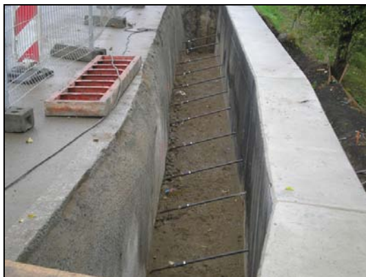
Obr. 4: Zemní kotvy TITAN 30/16
