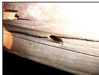
Obr. 10: Ukázka míry poškození dřevěných konstrukcí krovu se zřetelnou ukázkou požerků a výletových otvorů tesaříka krovového ( Hylotrupes bajulus ).
