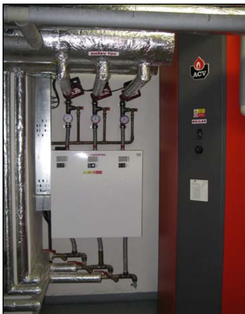
Obr. 5: Elektrokotel 3 x 20 kW [4]
