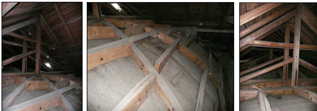
Obr. 12: Dřevěná trámová konstrukce krovu a bednění klenby kostela
