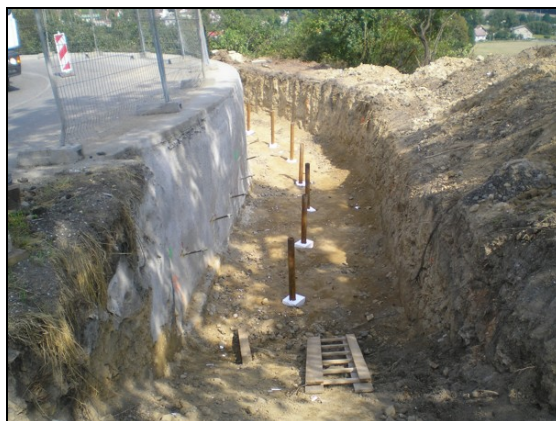
Obr. 2: Mikropiloty Ø 89/10 mm
