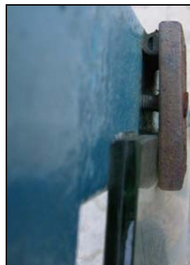
Obr. 5: Chybné uchycení skleněné výplně k ocelovému rámu
