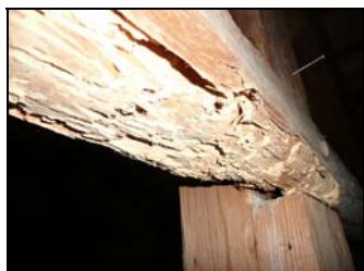
Obr. 10: Ukázka míry poškození dřevěných konstrukcí krovu se zřetelnou ukázkou požerků a výletových otvorů tesaříka krovového ( Hylotrupes bajulus ).
