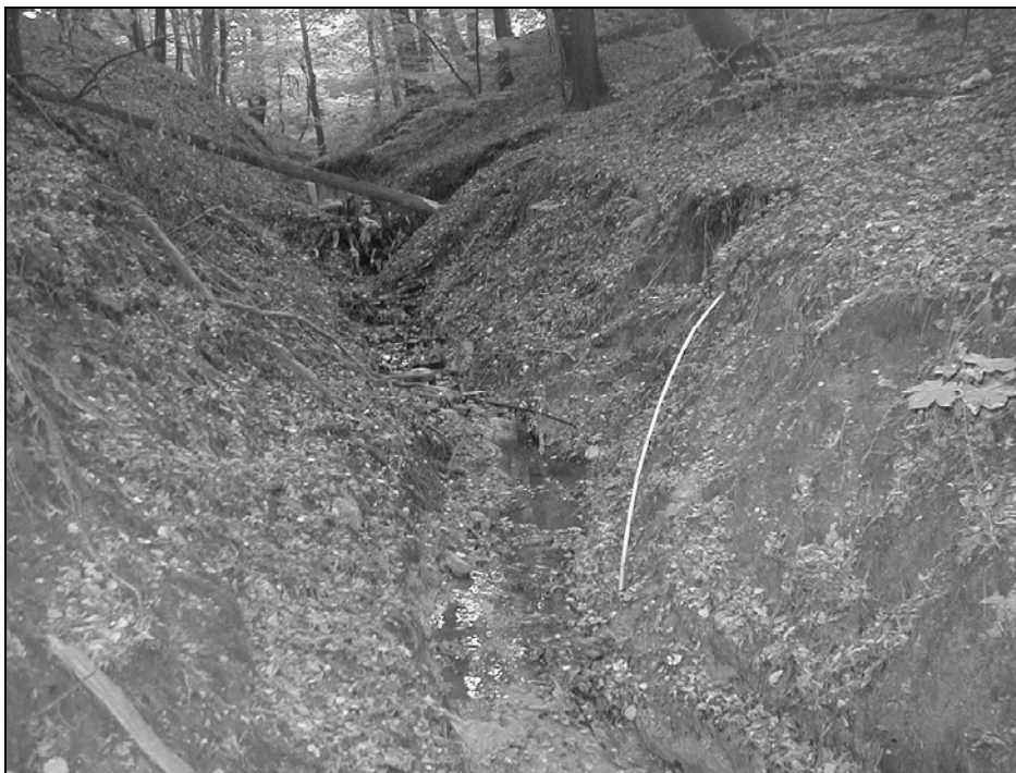
Obr. 1: Fotografie stávajícího stavu svahu potoku Výšina
