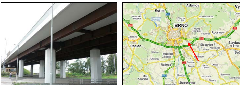
Obr. 7: Silniční most M1 – Černovická terasa Brno
