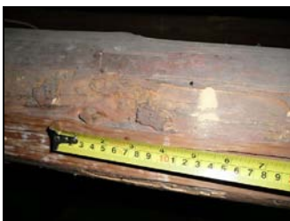
Obr. 10: Ukázka míry poškození dřevěných konstrukcí krovu se zřetelnou ukázkou požerků a výletových otvorů tesaříka krovového ( Hylotrupes bajulus ).
