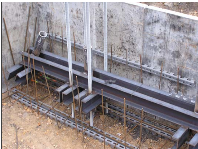
Obr. 4: Detail provedení základového pásu, kotevního roštu a mikropilot
