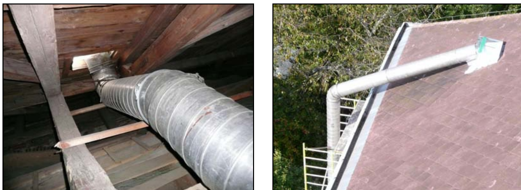
Obr. 13: Pohled z věže kostela na prostup horkovzdušného potrubí střechou kostela a jeho následné rozvedení v interiéru krovu.
