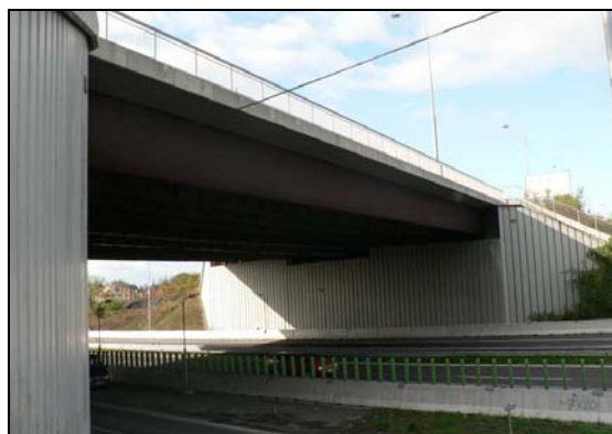
Obr. 5: Mosty s omezeným provětráváním vedoucí nad vozovkou: vlevo – schematické znázornění; vpravo – typová ukázka mostní konstrukce, u které je vhodné při návrhu zohlednit vliv usazovaných chloridů (silniční a tramvajové mosty nad dálnicí D1 v Ostravě – rok výroby 2002)
