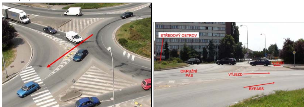
Obr. 12: Nevýrazné vodorovné dopravní značení (vpravo i vlevo), chybně instalované příčné prahy (vlevo – viz také obr. 13)
