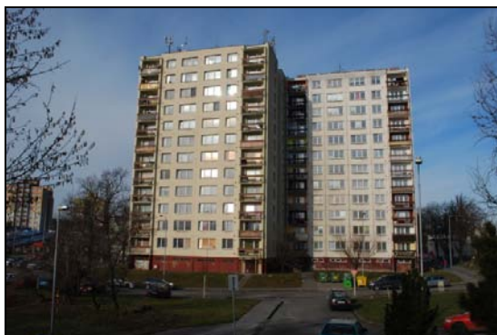
Obr.3: Fotografie objektu pro revitalizaci
