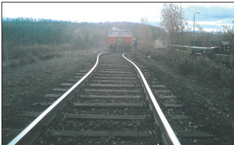
Obr. 3: Vybočení koleje rok 2010
