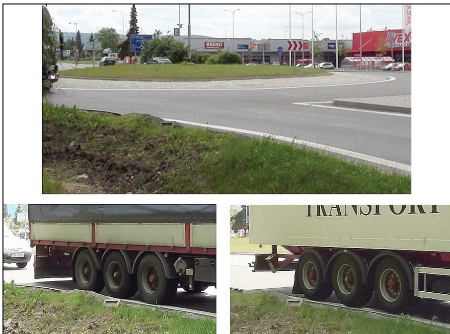
Obr. 1: Okružní křižovatka Masarykova – parking Tesco ve Valašském Meziříčí (nahore) s detailními pohledy na pojezdění vodící čáry na výjezdu (dole)
