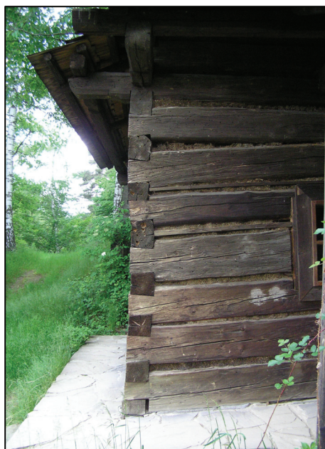
Obr. 6: Pohled na svislý kout u obvodových stěn dřevěné roubené stavby
