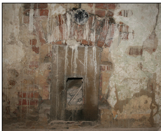
Obr. 10: Příkládací ostění v chodbě 208 východního křídla v patře upravené na vymetací otvor novodobého topeniště, foto, 2011
