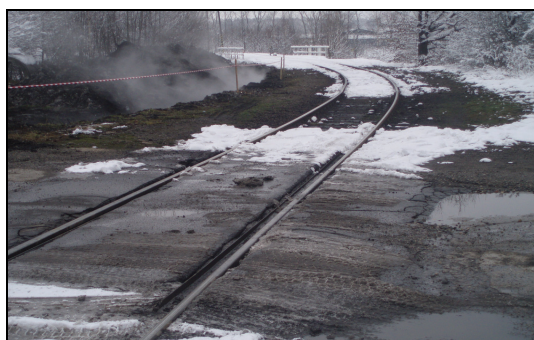
Obr. 6: Zápar v koleji chlazený zasakováním a zahoření prachů
