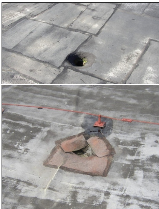
Obr. 1 a 2: Příklady defektního provedení vpusti v detailu střechy
