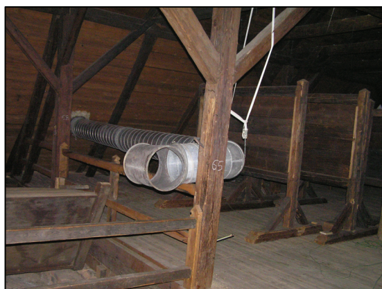
Obr. 3: Pohled na rozvodná potrubí s vyústěním v sanovaném prostoru
