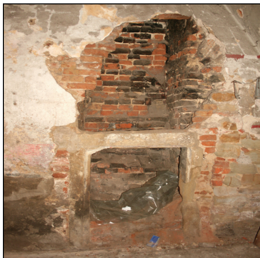
Obr. 9: Příkládací portál ve východní zdi průjezdu 101 pro obsluhu topeniště v m. č. 114, foto, 2011
