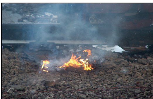
Obr. 6: Zápar v koleji chlazený zasakováním a zahoření prachů
