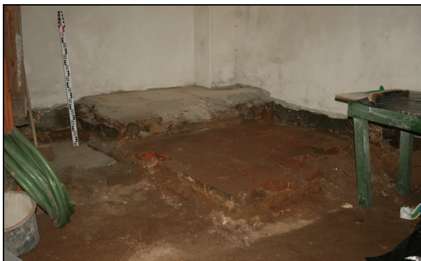
Obr. 8: Rychvald, varná podesta využitá jako podesta kamen v m. č. 128 - 131, foto, 2011
