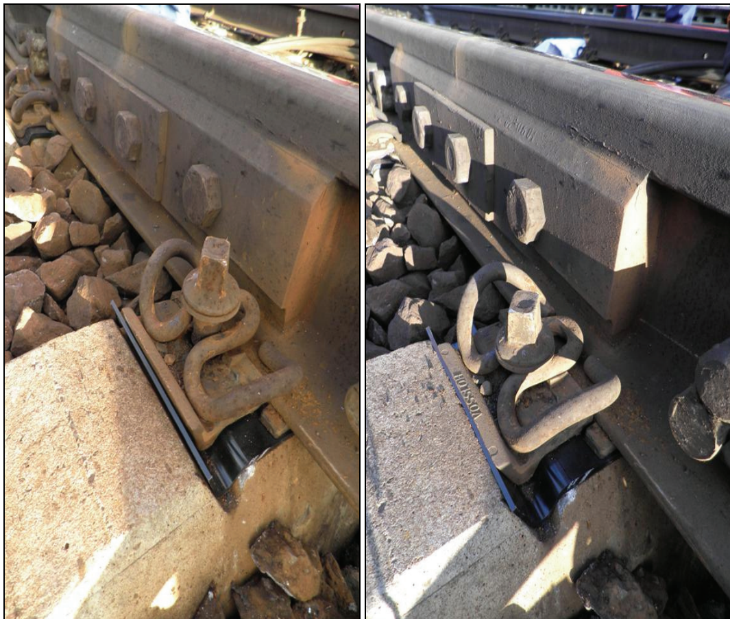
Obr. 3: Vlevo podložka Apw150 před utažením vrtule R1 na upevňovacím uzlu a vpravo po dotažení vrtule R1 uzlu upevnění
