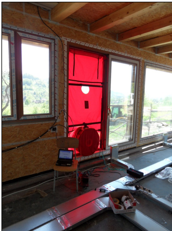
Obr. 1: Měření průvzdušnosti pasivního domu v Novém Hrozenkově metodou Blower Door Test
