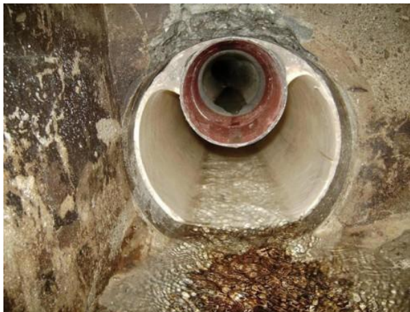
Obr. 4: Specifický rukávcový relining. Zdroj: autoři článku
