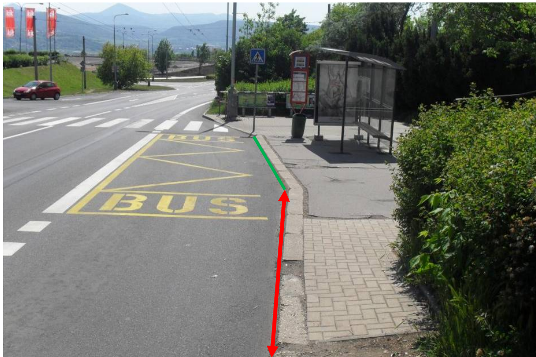
Obr. 5: Prodloužení nástupní hrany do vyřazovacího úseku zastávky
