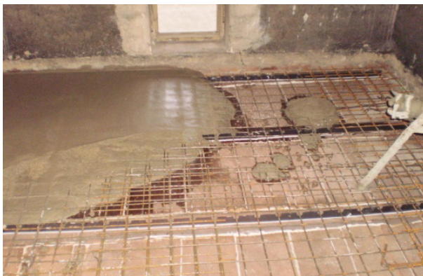
Obr. 8: Betonáž železobetonové desky spřažené s dřevěnými trámy
