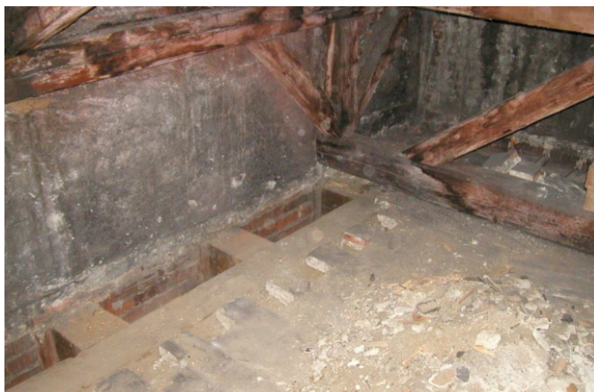
Obr. 5: Sonda ve stropní konstrukci na půdě
