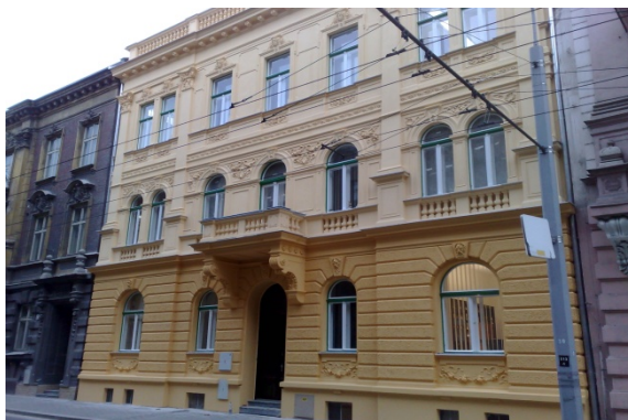
Obr. 3: Celkový pohled na fasádu rekonstruovaného objektu se spřaženými dřevo betonovými stropy
