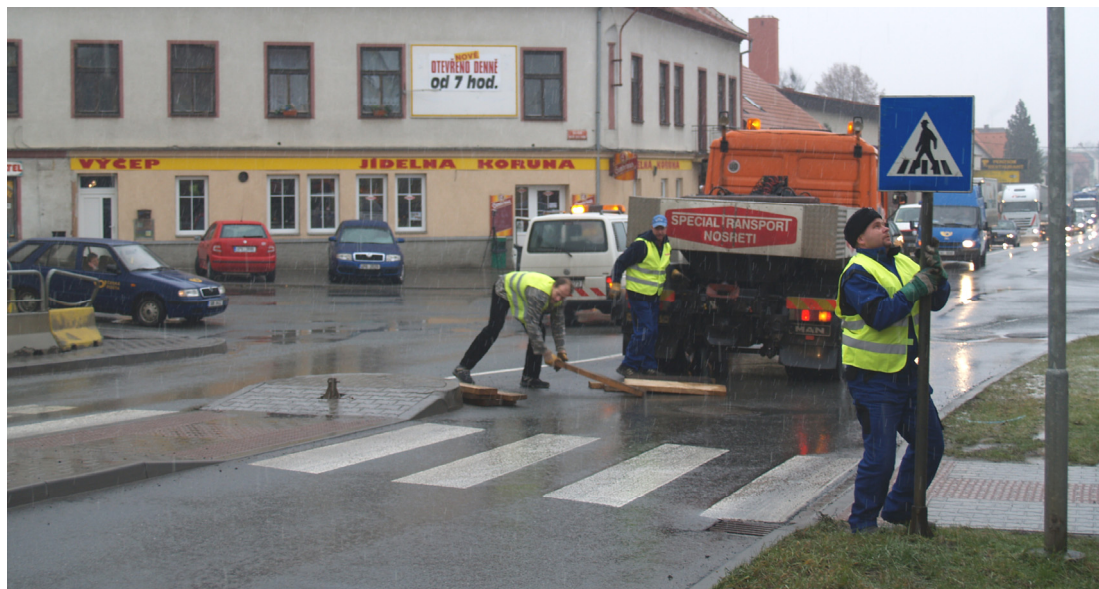
Obr. 2: Demontáž svislého dopravního značení a podkládání ostrůvku (Foto: Ing. Petřů)
