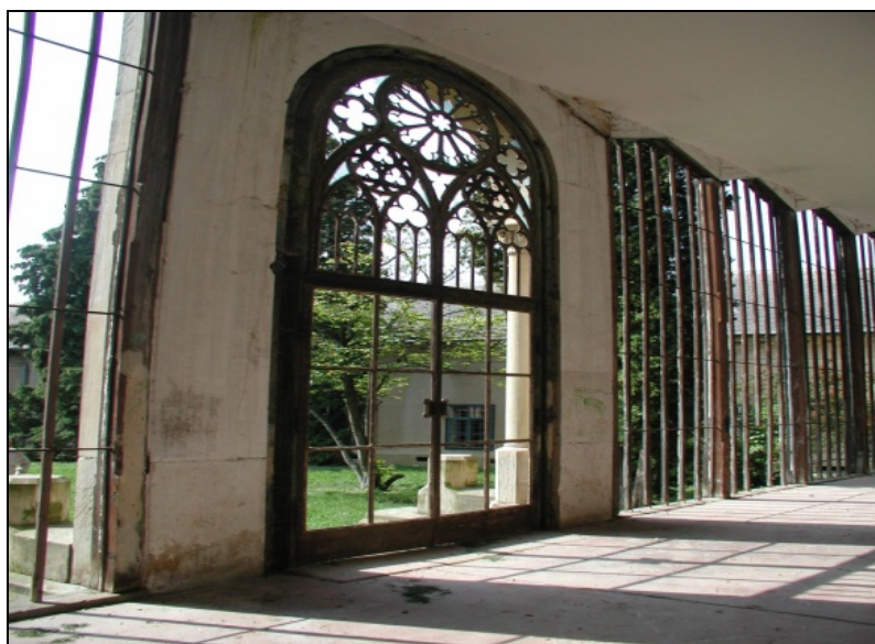
Obr. 7: Oranžerie v Čechách p. K. před rekonstrukcí
