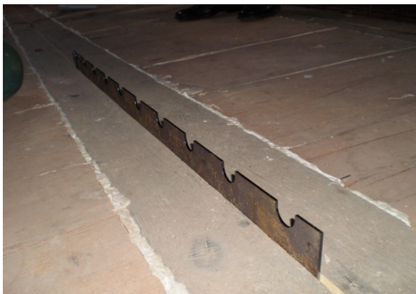
Obr. 6: Zkouška osazení lepené smykové lišty
