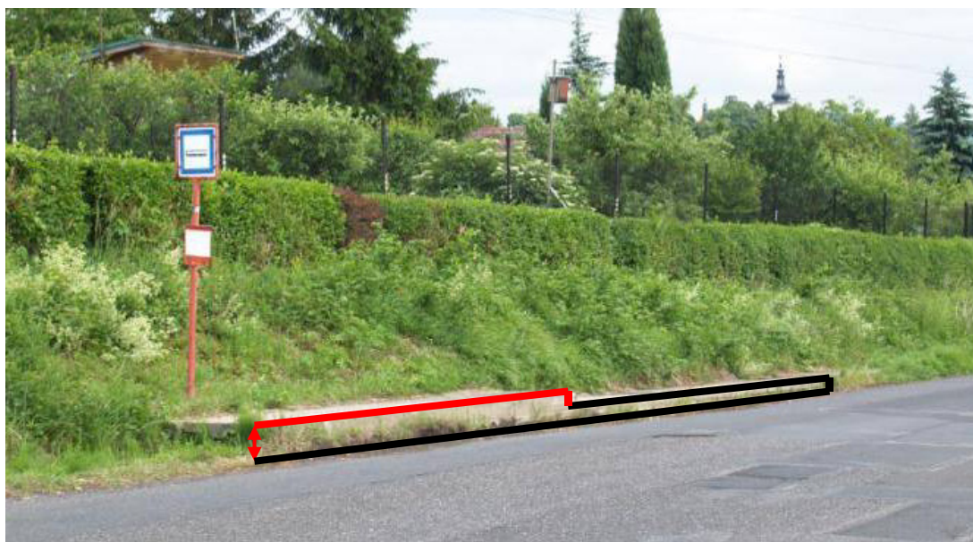
Obr. 9: Vysoká výška nástupní hrany v první polovině zastávky složené s panelů
