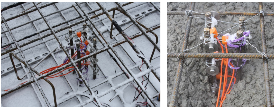
Obr. 5: Osazení měřícího pilíře do konstrukce
