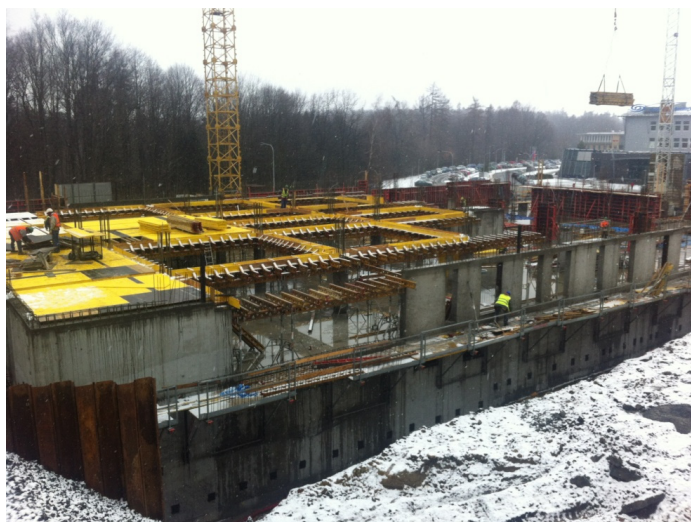
Obr. 11: Pohled na rozestavěný železobetonový objekt superpočítače IT4
