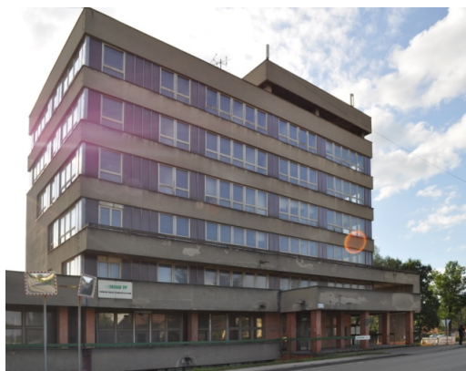
Obr. 2: Fotografie administrativní budovy
